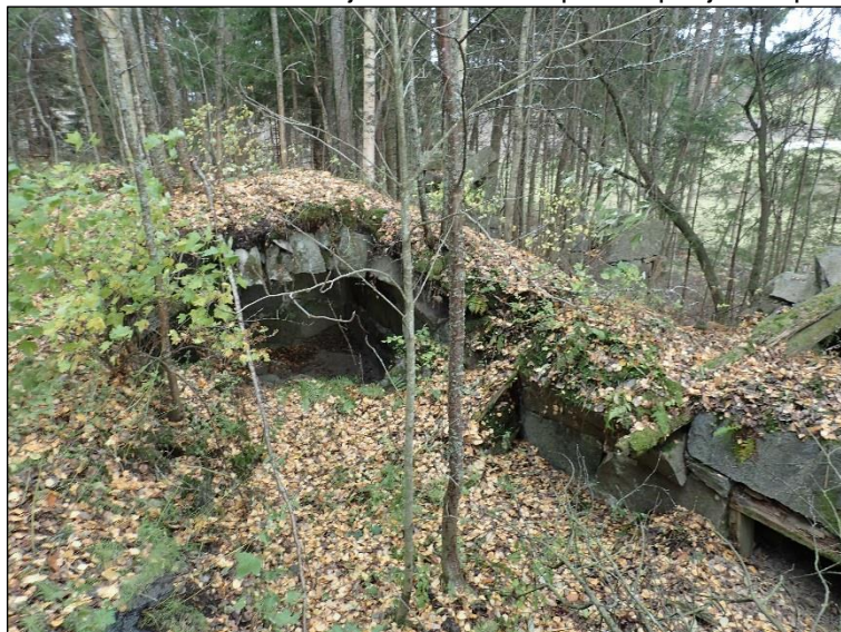
Alla: Itäreunan nuoremman rakennuksen jäännöksen sisäpuolen pohjoisempi kellari. Koilliseen.
