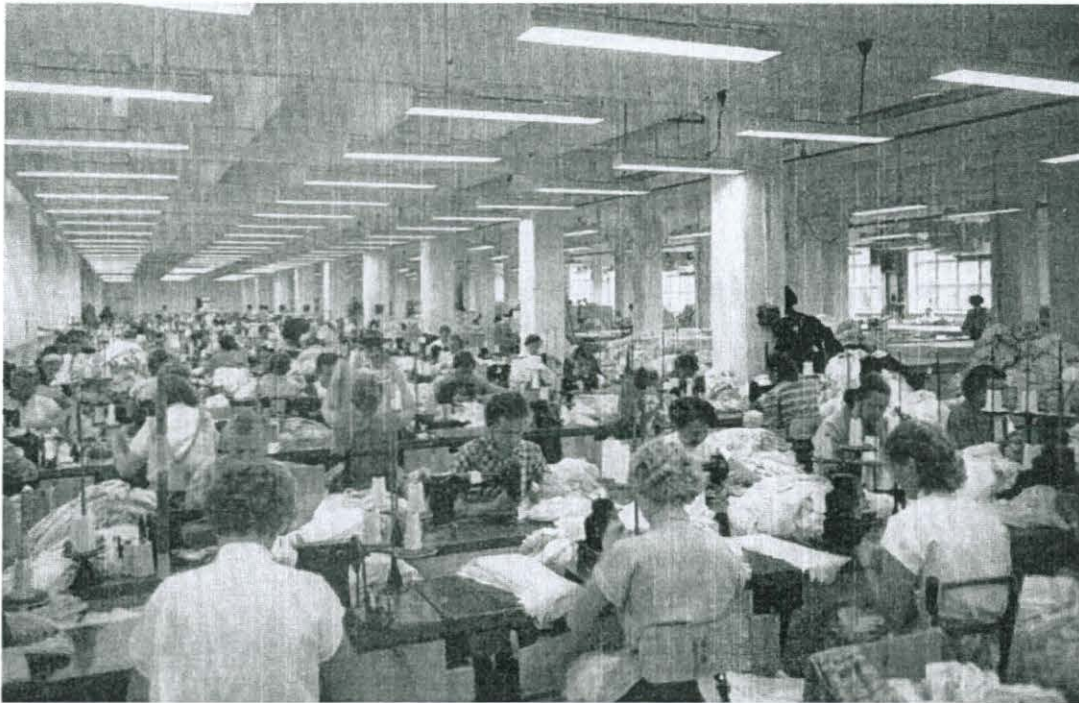
Kuva 44. Säteriompelimo uusissa tiloissaan v. 1955.
