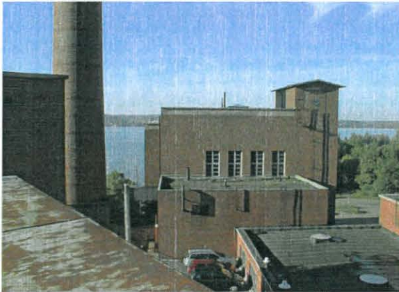
Kuva 37. Voimalaitoksen edessä kattilahuone v. 1966.
