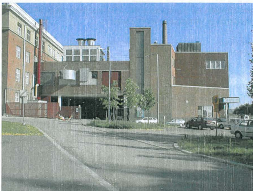
Kuva 32. Viimeistämön pääty ja sen laajennus vasemmalla.
