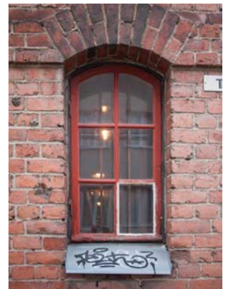
Telakan ikkuna Tullikadun puoleisessa julkisivussa.
