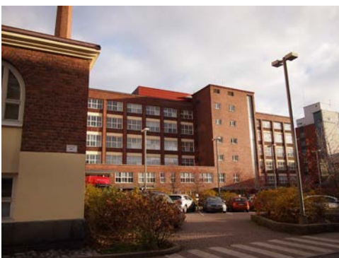
Vuonna 1954 rakentuneen osan julkisivua sisäpihan puolelta.
