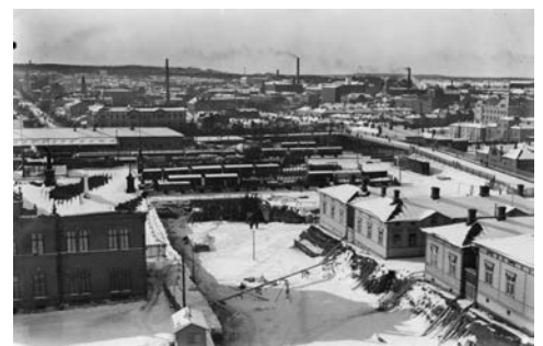
Itsenäisyydenkadun tunnelin työmaa vuonna 1933. (E.M.Staf, Tampereen museot)
