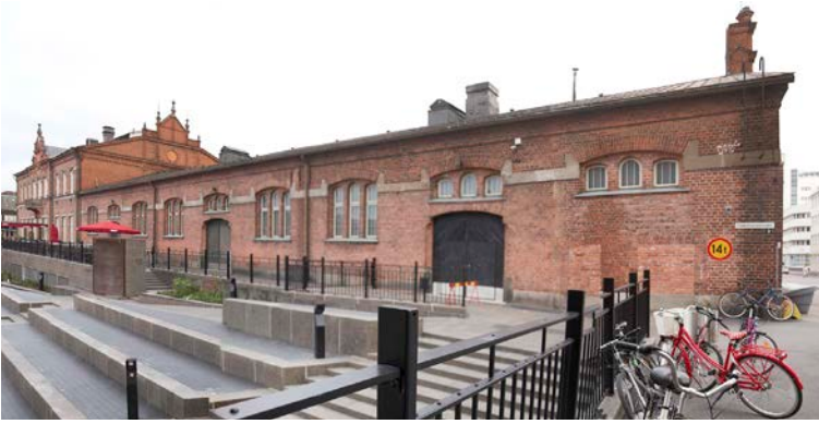
Pakkahuoneen aukion puolelta. Julkisivussa erottuvat kaksi umpeen muurattua oviaukkoa.
