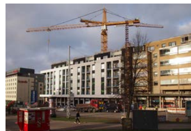
Luminary rakenteilla lokakuussa 2017. Torniosaa ei vielä erotu Itsenäisyydenkadun puolelle.
