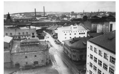
Åkerlundinkatua vuonna 1954: Kuvassa Tampereen rakennuskonttorin rakennus vastapäätä HMK:n makasiinia sekä oikeassa kulmassa Lääketehtäas Starin rakennus. (Kuva: Reino Branthin, Tampereen museot)
