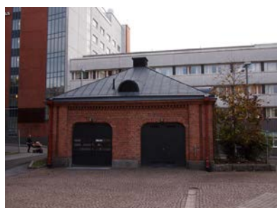
Entinen tallirakennus sisäpihan puolelta.
