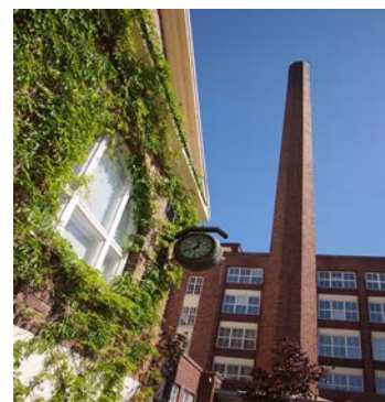
Suojeltu piippu sisäpihalla.
