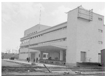
SOK:n rakennus rakenteilla 1936. Rata jatkaa Tullikatua pitkin. (Kuva: E. M. Staf, Tampereen museot)
