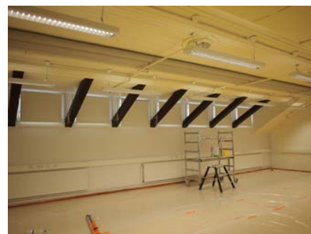
Kattorakenne näkyvillä ullakkokerroksessa.
