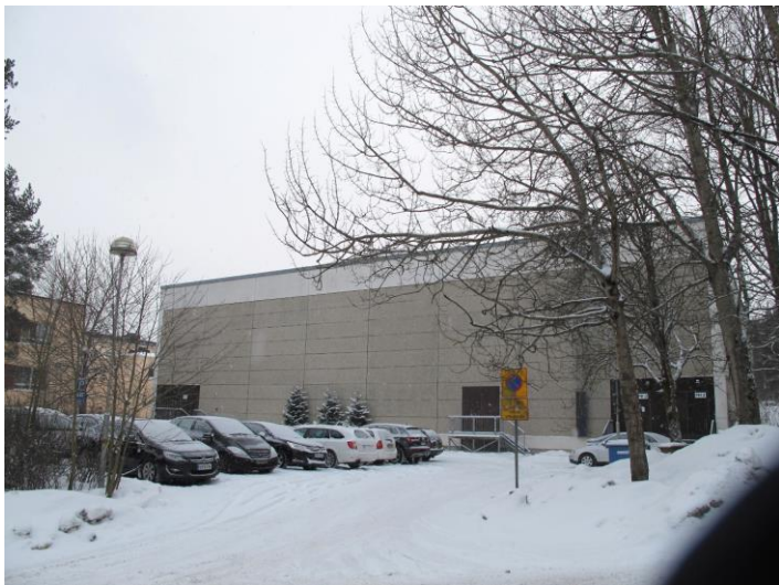
Palloiluhallin pohjoispäädyn betonimassaa Vesilinnankadulta.
