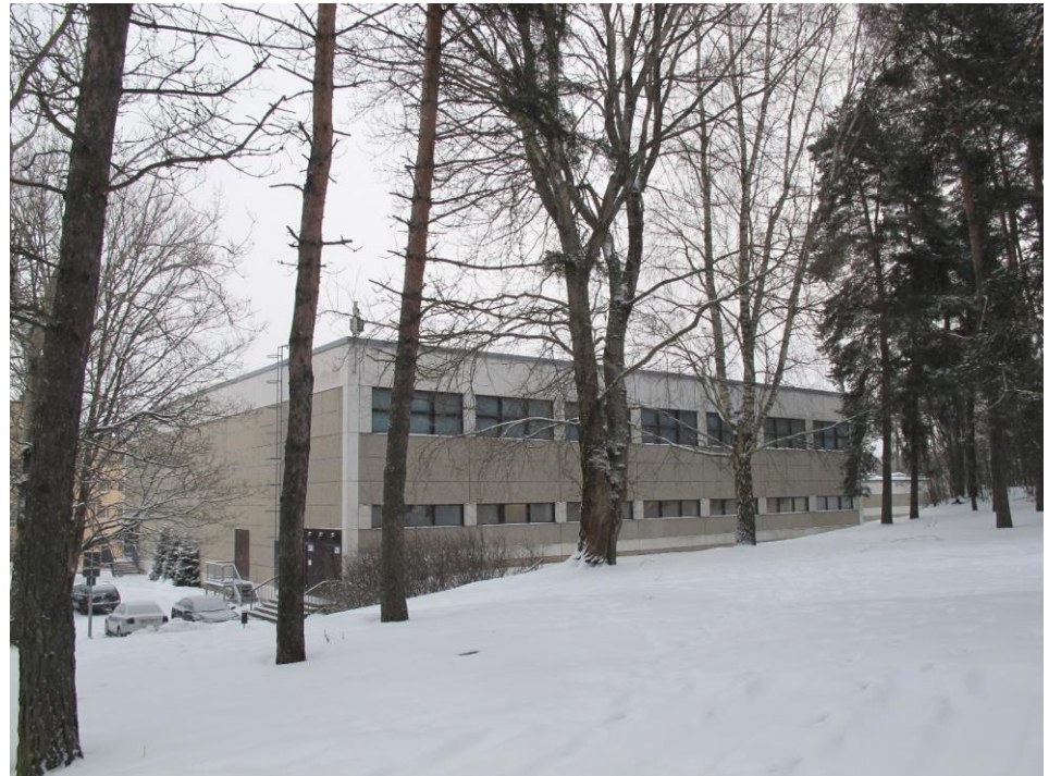
Palloiluhallin länsipuoli Vesilinnankadulta. Yläosan ikkunat valaisevat palloiluhallia ja alaosan nauhamainen ikkunarivi kuntosalitilaa.
