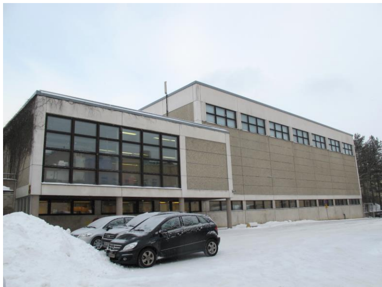
Pyynikin palloiluhallin itäsivu kohti ammattikoulua. Rakennus maastoutuu huomaamattomasti Pyynikin rinteeseen. Näyttävän osa suuntautuu kohti itää ja ammattikoulun sisäpihaa.
