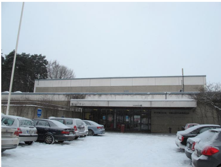
Pääsisäänkäynti rakennuksen eteläisivulla.
