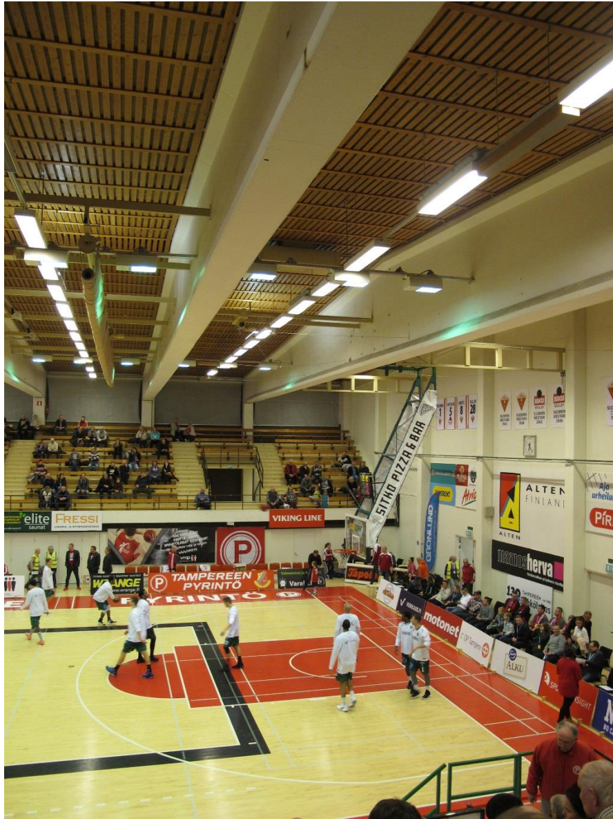
7 Hallin kattorakenteet, betonipalkit ja puupanelit
