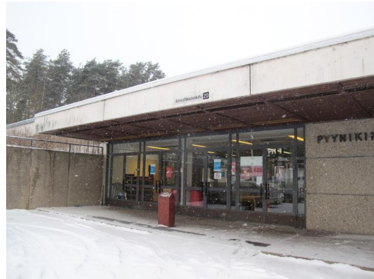
Pääsisäänkäynnin lippakatos. Katoksen alaosa on paneloitu tummalla puulla.
