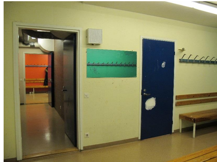
5 Pohjakerroksen pukuhuonetiloja. Pesu- ja pukuhuonetilat eivät ole juurikaan muuttuneet sitten 1970-luvun. Seinien maalipintoja on uusittu.
