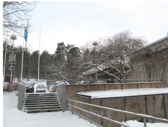
Rakennuksen eteläpuolella oleva portaikko kohti ammattikoulun sisäpihaa. Palloiluhallin eteläpuolen piha-alueetta rytmittävät ylätasanteella ja portaikon vieressä olevat betoniseinämät.
