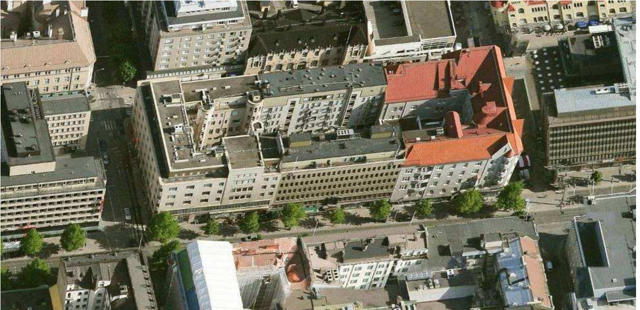
Ylhäällä: Viistokuva etelästä. Vasemmalla Tuotannontalo, keskellä Yhdyspankintalo ja oikealla Kansallispankintalo. Taustalla keskellä Ylioppilastalo. (Bing.com, 2017 Blom)
