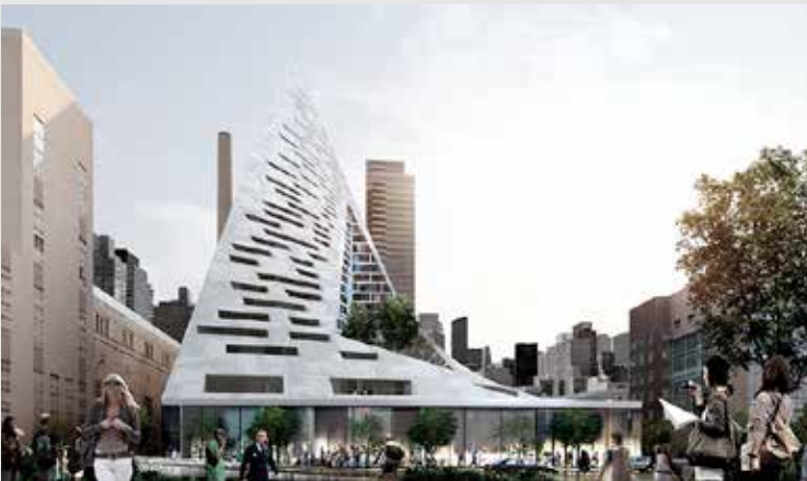
West 57th, Yhdysvallat, New York / BIG. Visiokuva, projektia rakennetaan parhaillaan. www.big.dk/#projects-w57
