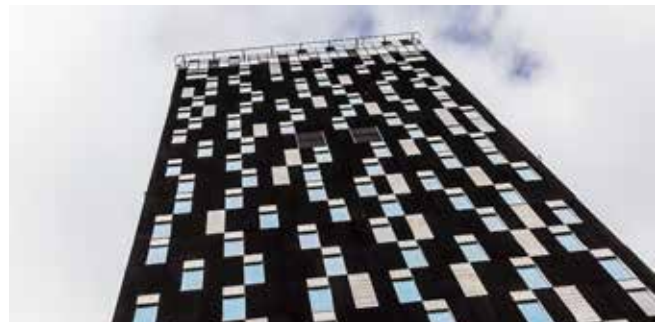
Solo Sokos Hotel Torni Tampere, Arkkitehtuuritoimisto Seppo Valjus Oy, www.sokoshotels.fi
