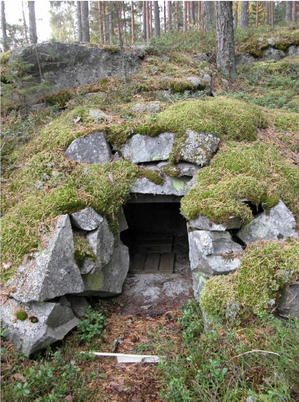
Kivikellari (rakenne 2), kuvattu pohjoisesta. 29.9.2009, Marjo Koskinen.
