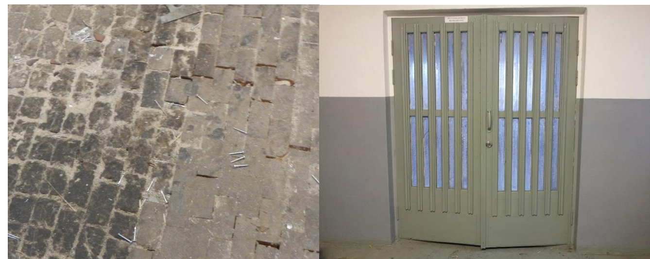
Oikealla ylhäällä rakennuksessa toimiva puyutyöverstas. Alakuvissa vasemmalla vanhan osan alkuperäinen lankunpätkestä ladottu pajan lattia. Oikealla uudemman osan yläkerrassa sijaitsevan ruokalan alkuperäinen ovi.
