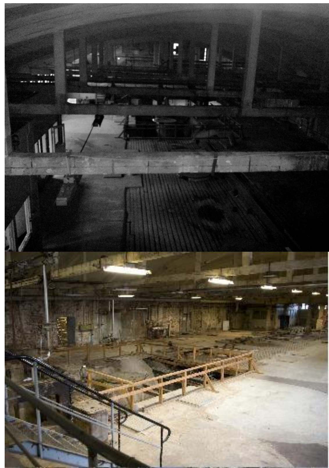
Vasen puoli, torniosan julkisivussa näkyvät sen useat korotus-, laajennus- ja muutosvaiheet. Oikealla alin kuva valkaisuosasto vuonna 2008 kemihierretehtaan toiminnan loppuvaiheessa. Kuvaaja Marika Tamminen. Vapriikin kuva-arkisto.
