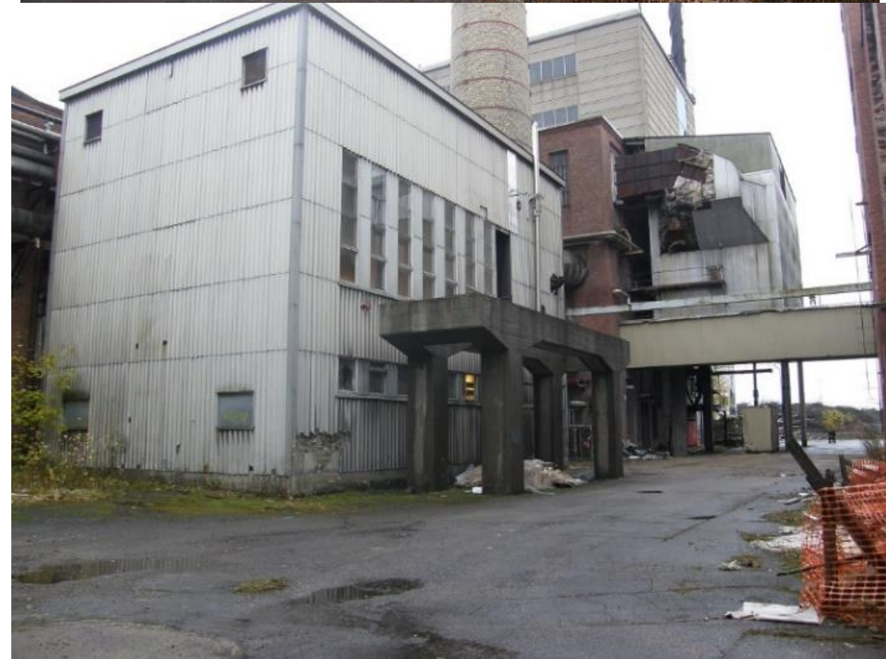
Kuvat: vasemmalla vuoden 1914 konehuoneen itäjulkisivua, vasemmalle jää sen matalampi pannuhuone ja oikealle kahta rakennusta toisen kerroksen korkeudella yhdistäv kytkinlaite vuodelta 1959. Ylhäällä oikealla nuorempia rakenteita vuosilta 1972,1959 ja 1950. Alhaalla turbiinisali vuodelta 1968.
