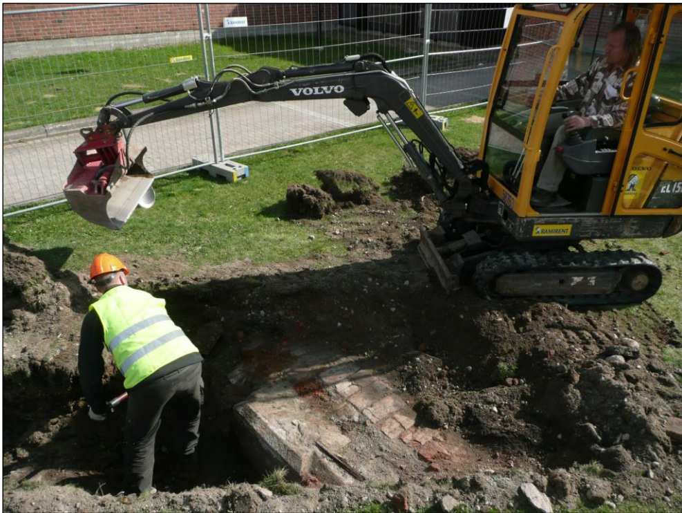
Kaivaustyötä. Mikko Helminen kuopassa ja Rostedt kaivinkoneessa.
