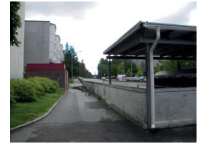
Sisäänajo maanalaiseen pysäköintiin.
