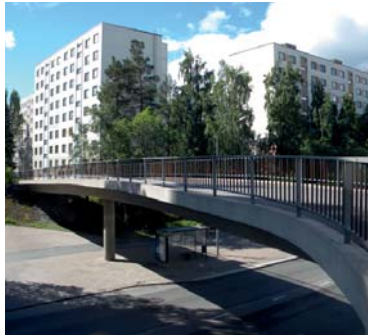
Valtaraitin silta yli Opiskelijankadun.
