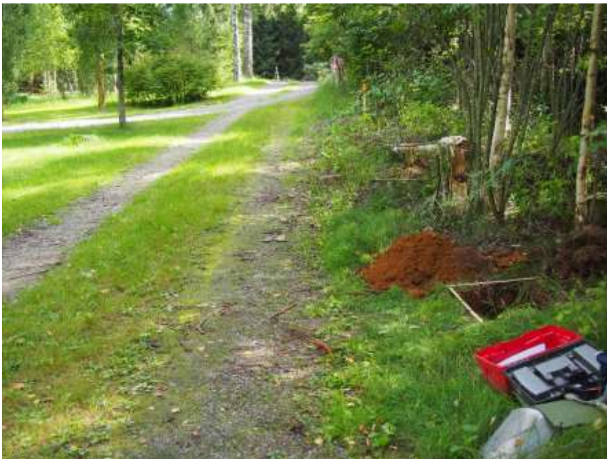
Kuva 2. Tutkittua ja paaluin maastoon merkittyä, suunniteltua maakaapelilinjausta pihatien länsipuolella. Etualalla koekuoppa 13. Kuvattu pohjoisesta. (Kuva: Urjala Neittenlinna 2017: 1)
