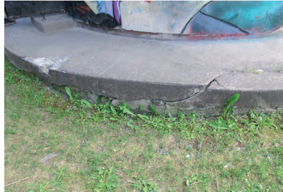
Räystäään puuritiä on lahonnut. Jalustan betonirakenne on haljennut.
