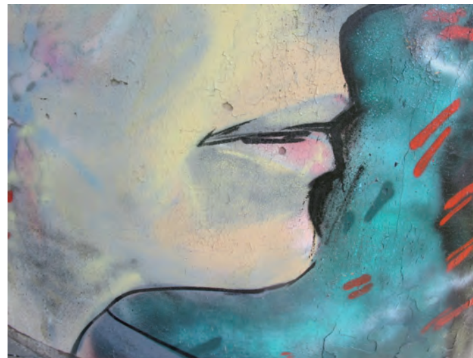
Graffittien pintamaali hilseilee ja on osittain irronnut alustastaan. Vaurioita maalauksiin on myös aiheuttanut alustastaan irtoavat julkisivurappaukset.
