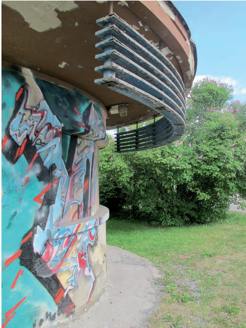
Räystäään puuritiä on lahonnut. Jalustan betonirakenne on haljennut.
