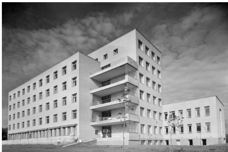
Kuva 5 Uusi sairaala kaakosta päin kuvattuna
