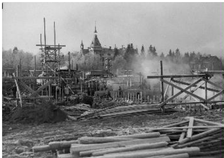
Kuva 2 Sairaalan rakennustyömaa. Taustalla näkyy huvilarakennus.
