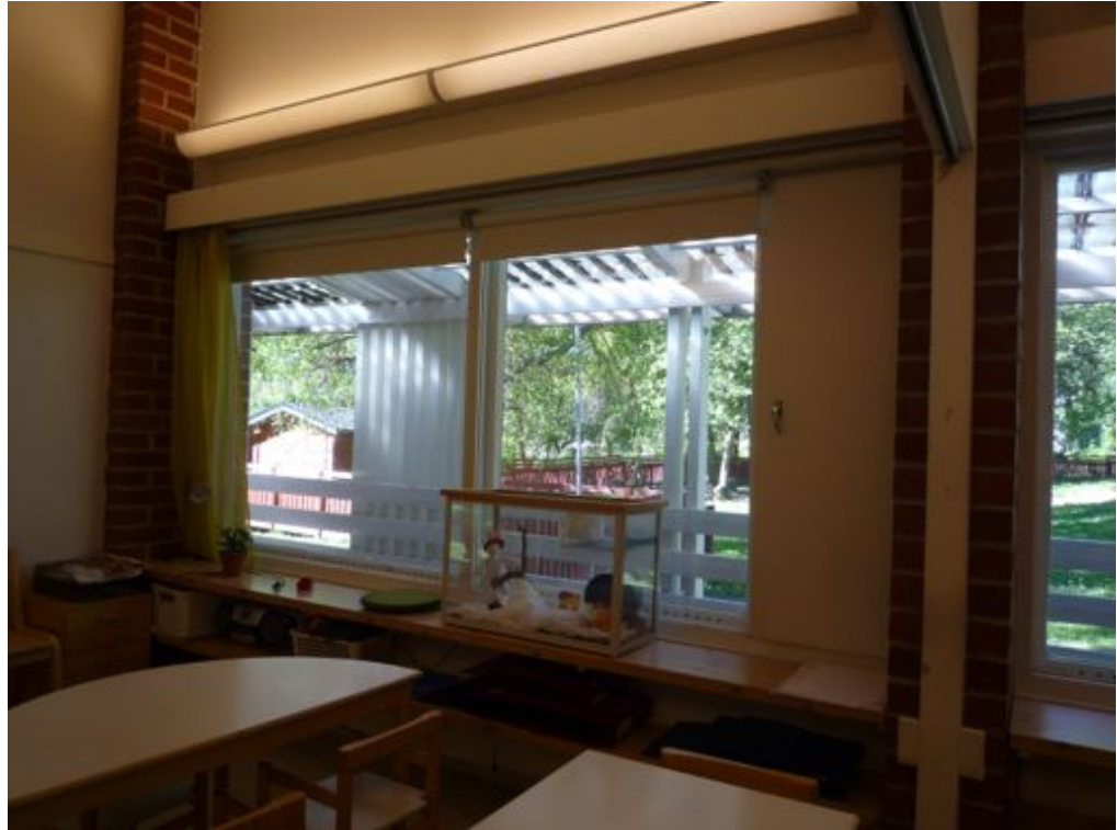
Osastihuoneen suuret ikkunat
