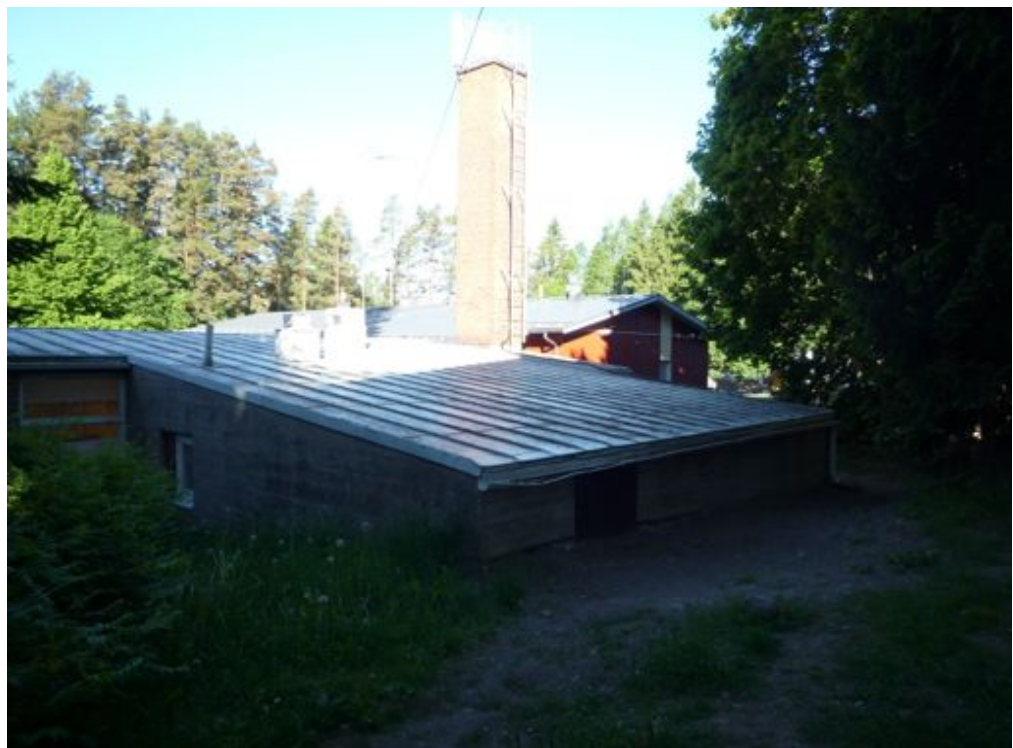
Osittain maanalainen kattilahuone
