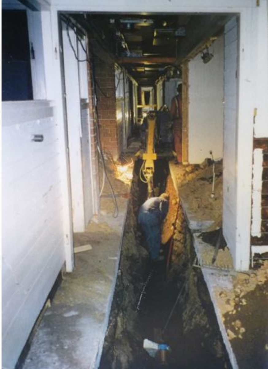
Kuva pitkästä käytävästä peruskorjauksen ajalta 1997
