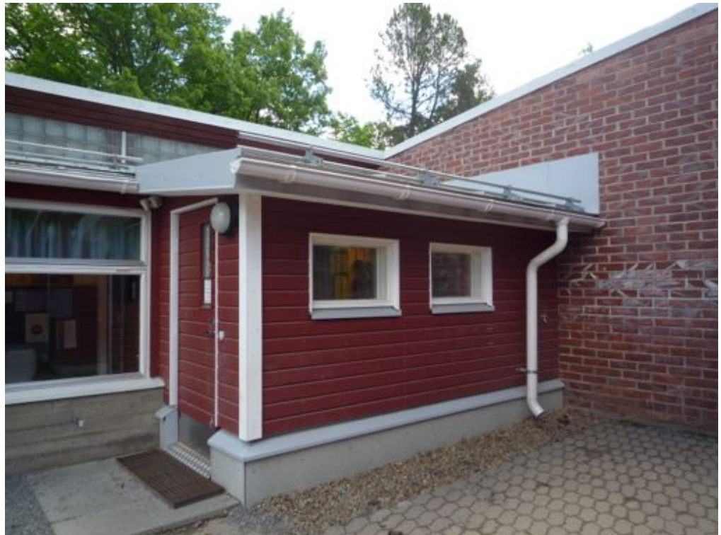
Vuoden 1983 peruskorjauksen yhteydessä lisätty tuulikaappi lounaisessa julkisivussa
