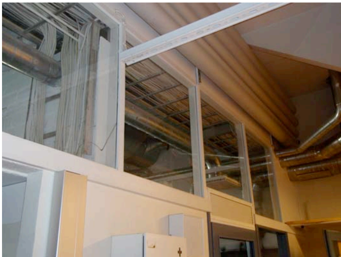
Iv-putkiasennuksia vanhojen kattoikkunoiden kohdalla.
