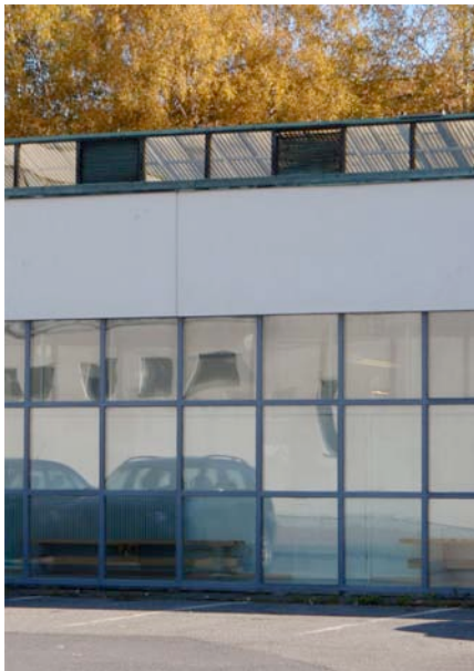
Sisäpihan siiven julkisivu ja kattoikkuna.
