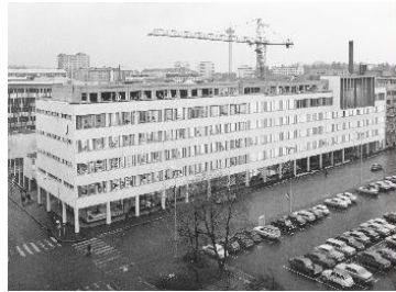
Virastotalo rakenteilla vuonna 1973 (kuva: Vapriikin kuva-arkisto).
