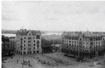
1900-luvun taitteessa Keskustorin eteläosaan nousi korkeita rakennuksia: Commerce 1899, Palanderin talo kahdessa osassa 1901 ja 1906 sekä Sumeliuksen talo 1901. Palanderin talosta puolet valmiina (kuva: Vapriikin kuva-arkisto).
