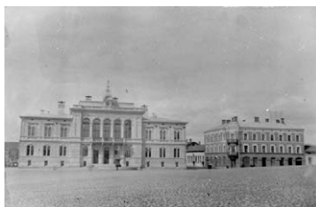
1880-luvun alussa Tampere sai vesijohtosysteemin, jonka myötä 3-kerroksisten kerrastalojen rakentaminen mahdollistui. Suihkukaivo on vuodelta 1884 ja toteutettiin vesijohdon yhteydessä. Tampereen raathuone ja Sandbergin talo vuonna 1890 tai 1891 (kuva: Vapriikin kuva-arkisto).
