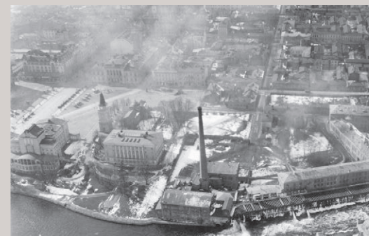
Ilmakuva vuodelta 1930 Frenckellin massahiomon rakennuksesta, joka sijaitsi kosken äärellä Frenckellin pannuhuoneen edessä. Aleksis Kiven kadun varrella nykyisen Kelan talon sekä Virastotalon paikalla sijaitsi pääosin matalien puurakennuksien muodostamia tiiviitä kortteleita (kuva: Valokuvaamo N. Rasmussen, Vapriikin kuva-arkisto).
