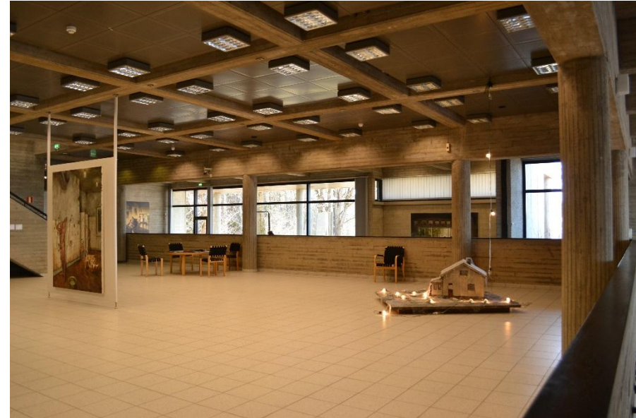
Näkymä koillisesta. Laattalattia uusittiin 1980/90-luvulla kokolattiamaton tilalle.
