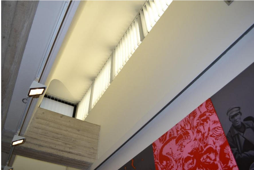
Valokuilu. Seinien yläosaa kiertää ikkunanauha, josta valo johtuu epäsuorasti alas.
