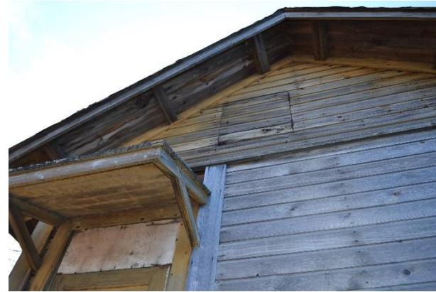
Lipallinen sisäänkäynti on pohjoispäädystä. Vinttitilaan ei ole käyntiä sisäpuolelta.
