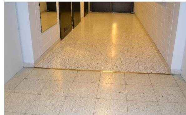
Lattiapintojen raja. Aulassa alkuperäinen sementtimosaiikkilaatta, toimistokäytävässä 1990-luvulla asennettu muovi-laatta.
