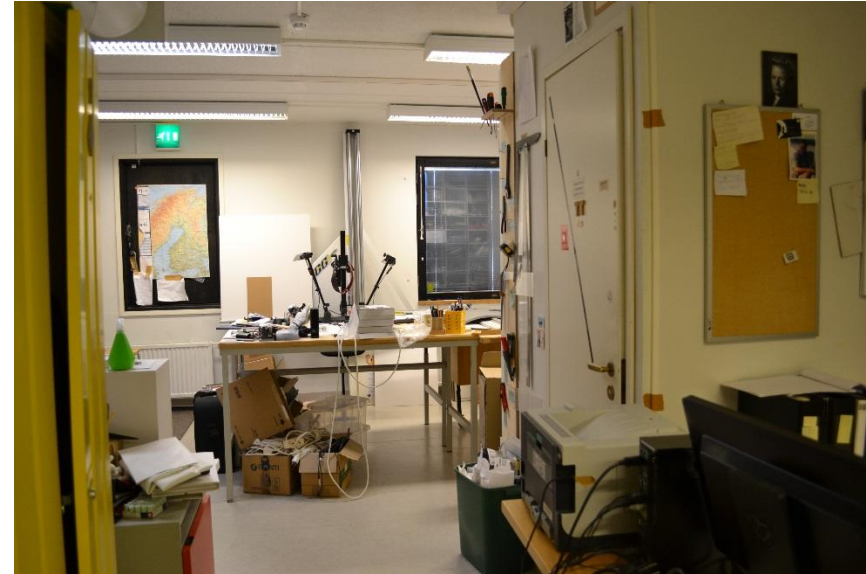
Näkymä eteistilasta työhuoneeseen. Vasemmanpuoleinen ikkuna on muutettu poistumistieksi.
