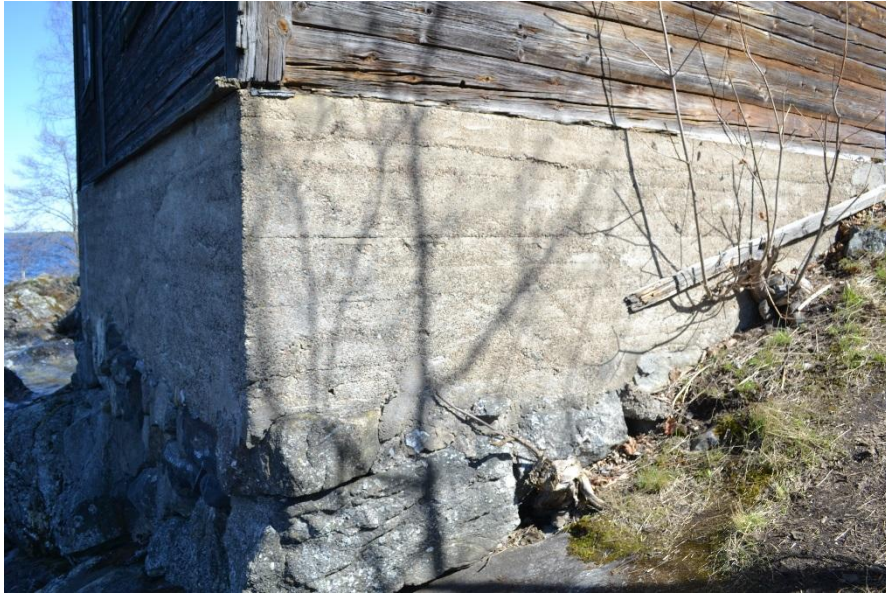
Rakennuksen länsikulma. Kivijalkaa on vahvistettu ja ilmeisesti korotettu betonilla.
