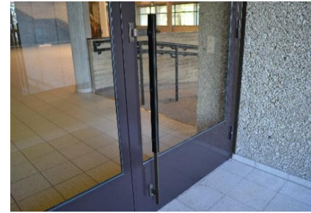
Kaikkissa lasisissa ulko-ovissa ja tuulikaappien ovissa on säilytetty alkuperäiset kädensijat mustaa kovamuovia ja messinkiä. Kuvassa alakerran tuulikaappi.
