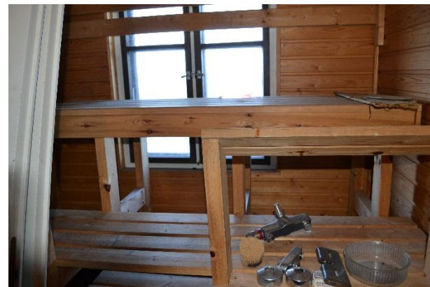
Pienestä löylyhuoneesta on ikkuna järvelle. Lauteet 1980-luvulta.
