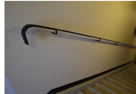
Kolmannen kerroksen entiseen talonmiehan asuntoon, nykyiseen työtilaan johtavassa porrashuoneessa on alkuperäinen käsijohde mustaa kovamuovia.
