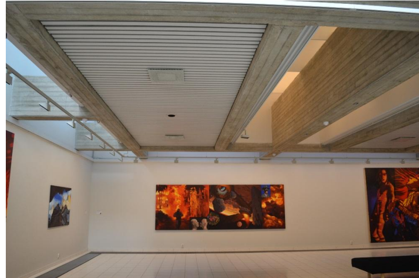
Betonipalkiston jäsentämässä kattonäkymässä vuorottelevat valokuilu, alaslaskettu, rimoitettu katto ja peitetyt kattoikkunat.
