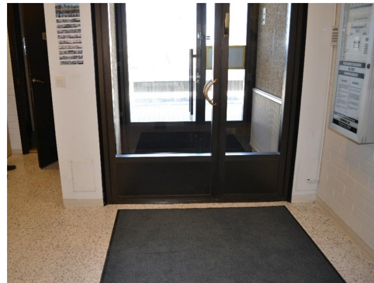
Sisäänkäynti toimistoaulaan, vasemmalla wc. Ulko-oven pitkänomainen kädensija on alkuperäinen, tuulikaapin vastaava vaihdettu kaarevaan.
