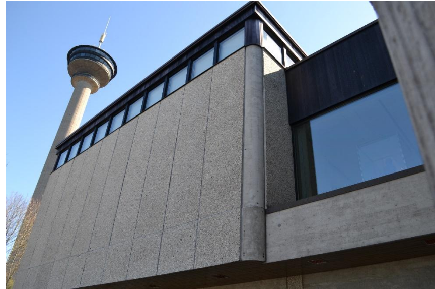
Pyöristetyt kulmat muotojen terävyyttä häivyttävät. Maisemaikkunat on vedetty katveeseen häikäisyn vähentämiseksi.
