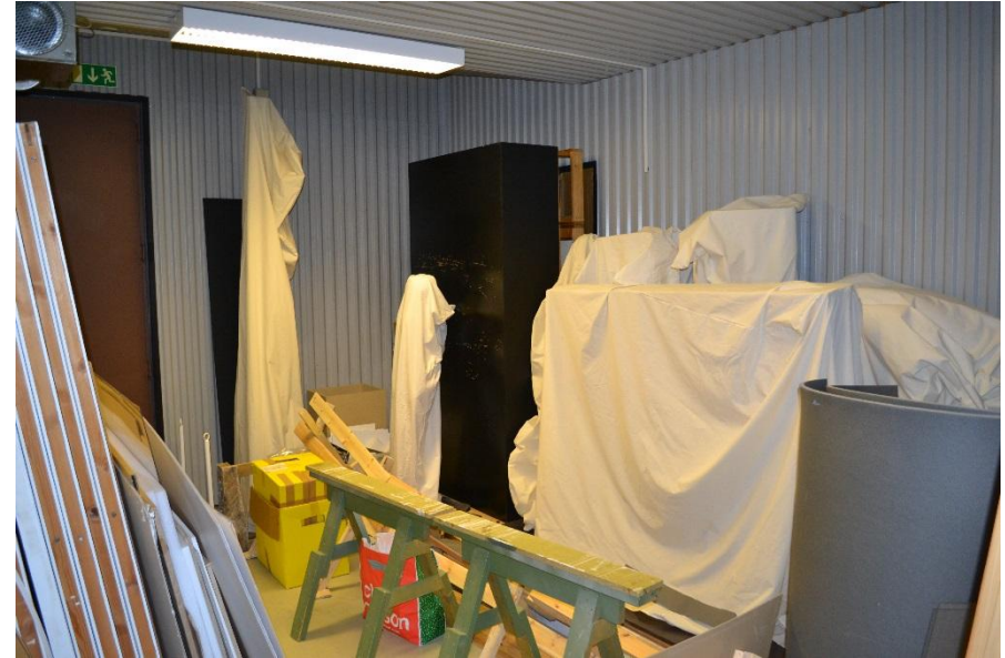
Tauluvarasto on kauttaaltaan vuorattu aaltopellillä.
