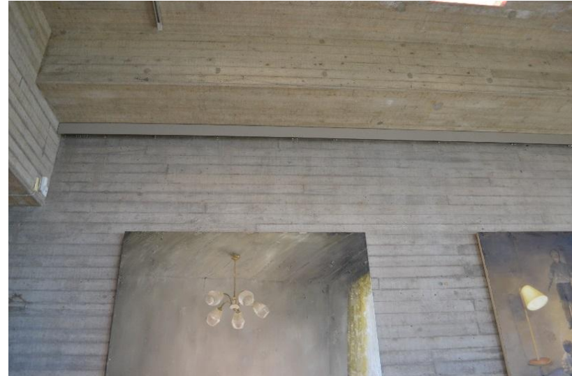
Yksityiskohta salin eteläpäädyistä. Seinien muottibetonipinta rajautuu kauniisti kattopalkistoon. Ylhällä ripustuskiisko, vaikka nykyisin ripustukset tehdään pääosin suoraan seinään.
