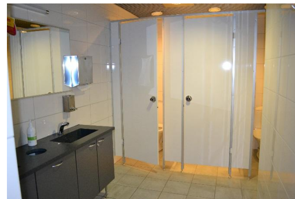
Wc-tilat on saneerattu 2000-luvun hillittyyn tyyliin. Sisäkatto alkuperäinen.
