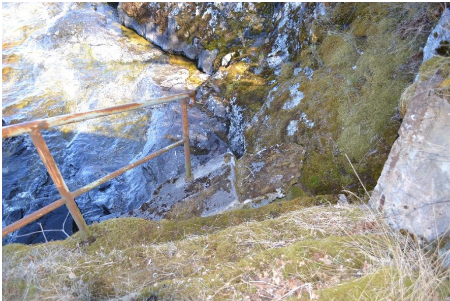
Betoniporras ja kaide toimivat uimaportaana.
