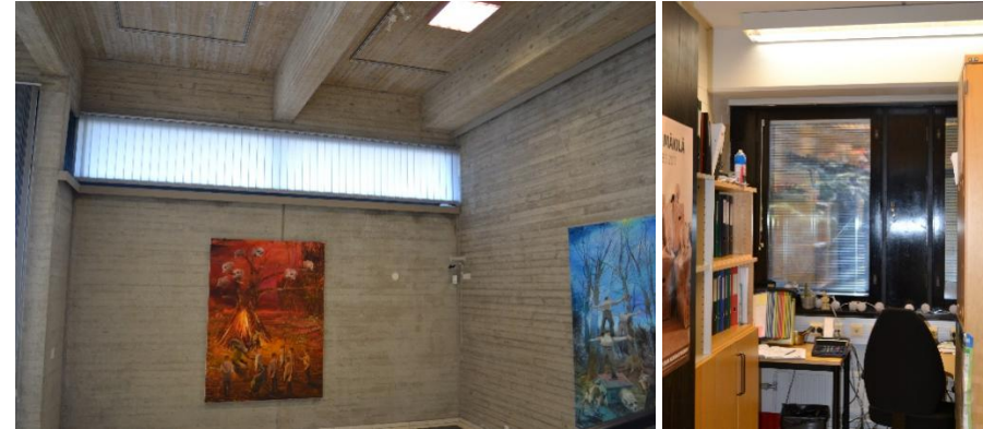
Näyttelysalien ikkunat on varustettu lamelliverhoihin. Toimiston ikkunoissa on sälekaihtimet.
