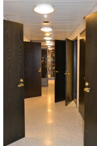
Työhuoneiden ja sosiaalitilojen ovet avautuvat toimsitokäytävään. Väliovet ovat rakennusajankohdalle tyypillisesti tummat ja messinkisin heloin varustetut.
