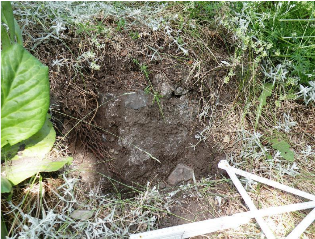
Mäkikatu 24:n betonista kattorakennetta. Kalle Luoto 7.7.2009
