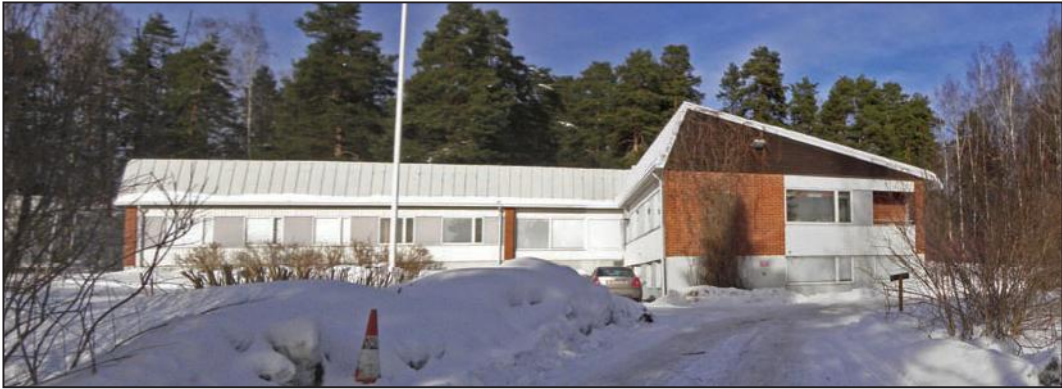
Raholan lastenkodin julkisivu etelään Voionmaankadulle.
