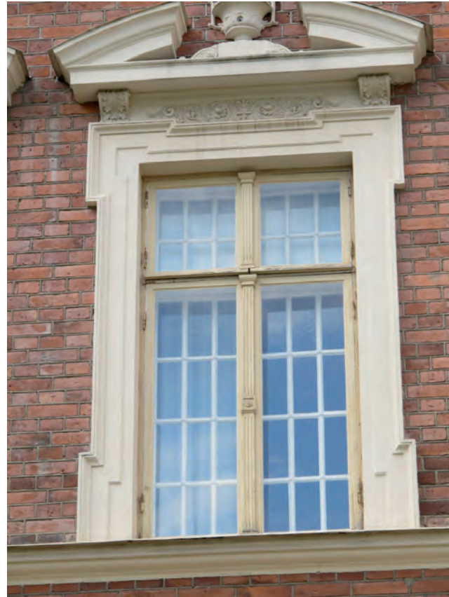
Päärakennuksen ikkunoita on uusittu 1990-luvulla alkuperäisen malliseksi. Sisäikkunoihin lisättiin ristikot, kun rakennus muutettiin sairaalaksi 1900-luvun alussa. Ikkunat on kunnostettavissa.
