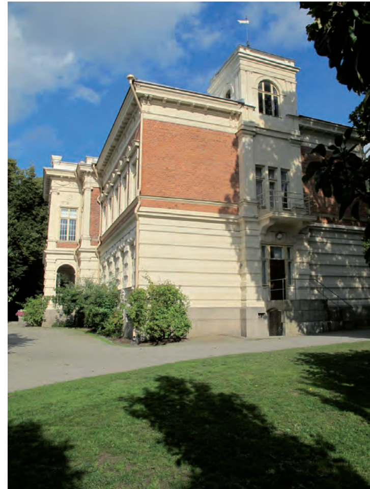
Päätyjulkisivu etelään syksyllä 2015.
