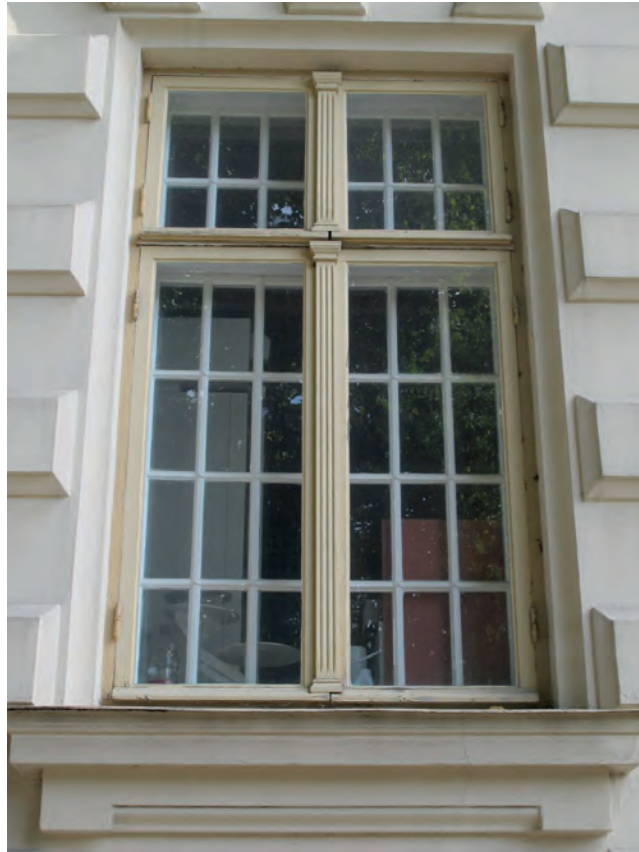
Päärakennuksen ikkunoita on uusittu 1990-luvulla alkuperäisen malliseksi. Sisäikkunoihin lisättiin ristikot, kun rakennus muutettiin sairaalaksi 1900-luvun alussa. Ikkunat on kunnostettavissa.
