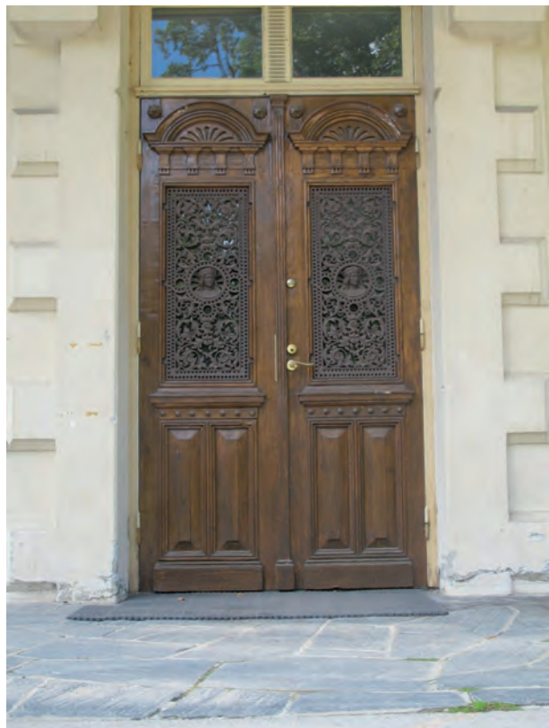
Alkuperäinen pääovi on hyväkuntoinen.
