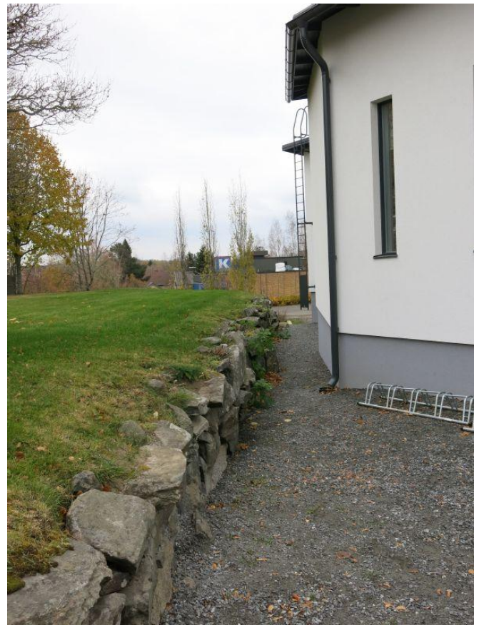
KYY 194 : 34 Akaan vanha hautausmaa , rakennukset ja rakenteet Heli Haavisto 25.10.2016
