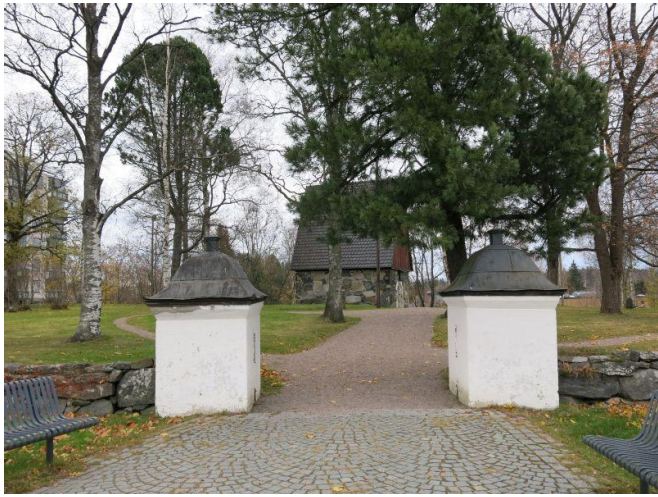
KYY 194 : 39 Akaan vanha hautausmaa , rakennukset ja rakenteet Heli Haavisto 25.10.2016
