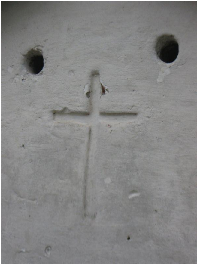
KYY 194 : 13 Akaan vanha hautausmaa , rakennukset ja rakenteet Heli Haavisto 25.10.2016
