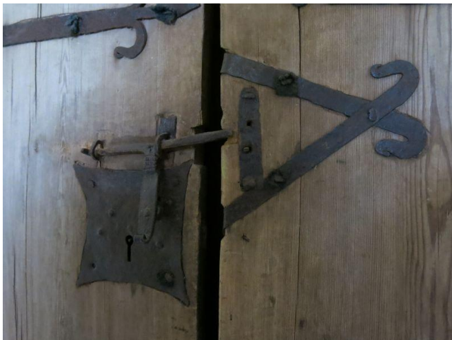
KYY 194 : 49 Akaan vanha hautausmaa , rakennukset ja rakenteet Heli Haavisto 25.10.2016
