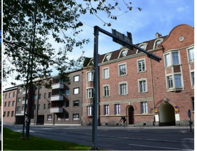
Eri-ikäiset punatiilirakennukset Mariankadulla ovat korttelin julkisivu viereisen arvoalueen, Pyynikin kirkkopuiston suuntaan.
