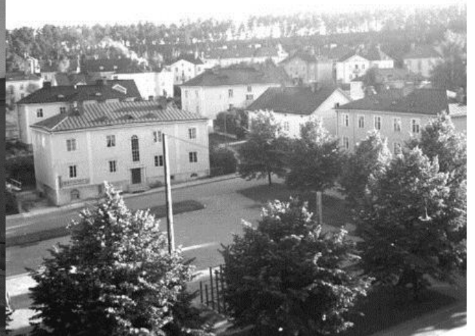
Näkymä Heinäpuistoon As Oy Veljeslinnan ikkunasta, 1952. KUVA Teuvo Mäkinen/Vapriikin kuva-arkisto
