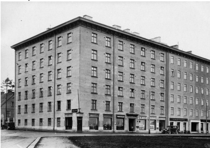
Vastavalmistuneet Pyykinrinte 1 ja 3 postikorttikuvassa. Alakerran liiketiloissa toimivat siirtomaatavarakauppa, parturi ja kirjakauppa. KUVA Hannu Rantakallio/Vapriikin kuva-arkisto
