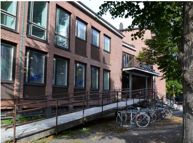
Uimahallin pääsisäänkäynti Korttelahdenkadulla. Pyynikin uimahalli on alueen ainoa jälleenrakennusajan punatiilinen rakennus.
