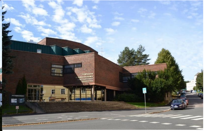
Konservatorio on torin ainoa punatiilinen rakennus. Sivuitse aukeaa näkymä Pyynikinrinteen asuinalueelle ja ammattikoululle. Pimeällä torin kulmauksen maisema ulottuu myös ikkunoista konservatorion aulaan.
