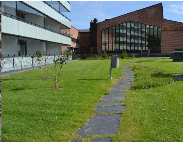
Peruskorjatun uimahallin ja huoneistohotellin uudisrakennuksen kulmauksessa on avoin puistotila. Näkymä uimahallin päätyikkunasta sisään on merkittävä lisä kaupunkikuvassa.
