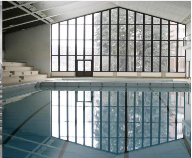
Uimahallin sisätila taideteoksineen on merkittävä 1950-luvun liikuntatila. Kuva vuodelta 2008 ennen peruskorjausta.
