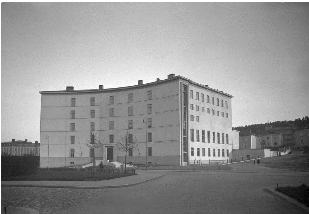
Lyseon koulutalossa on sekä klassistisia että funktionalistisia piirteitä. Julkisivun kaarimuoto toistuu torin eteläpään puistossa. KUVA E. M. Staf/Vapriikin kuva-arkisto
