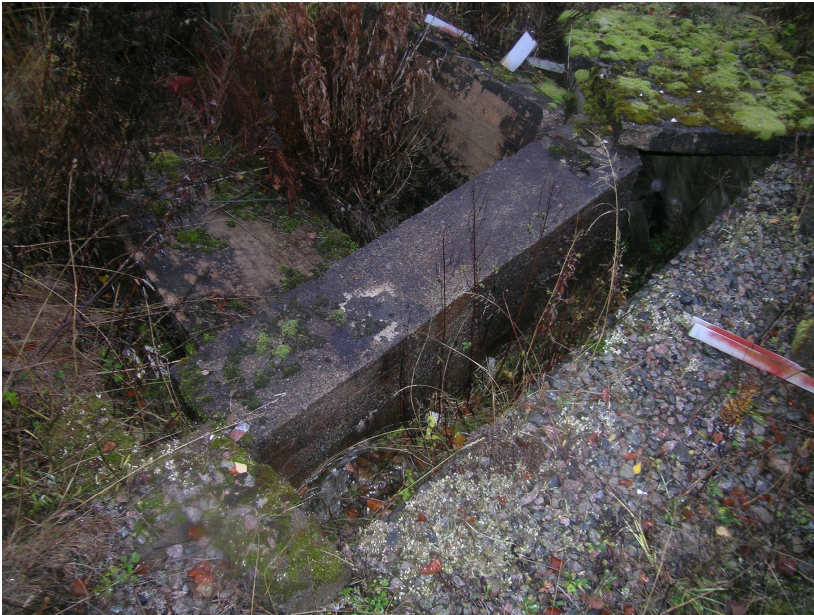
Kuva 3. Sepelikentän betonirakenteita. KY 167: 16.
