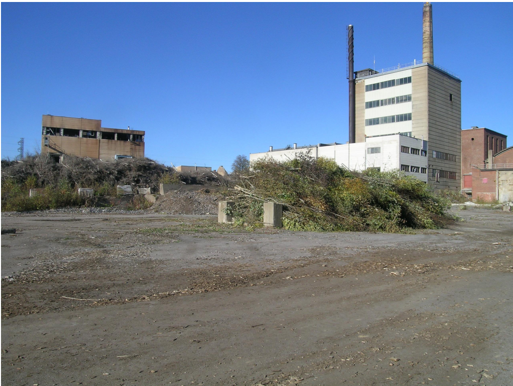
Kuva 1. Tehdasrakennuksia ja tuoreita hakkuujätetepinoja. Etualalla näkyvä kenttä on vanhaa ratapihaa, josta kiskot on purettu. KYY 167: 1.
