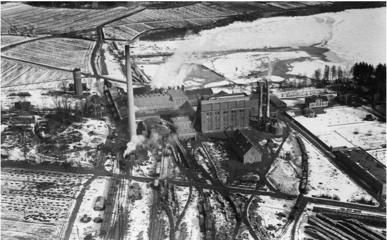
Ilmakuva 2. Ilmakuva selluloosatehtaasta 1930-luvulla koilliseen katsottuna. Kuvassa näkyy tehdasalueen raidejärjestelmän laajuus. Kuvaaja: Kalle Kurki. Tampereen museot TKA Kurki 54.
