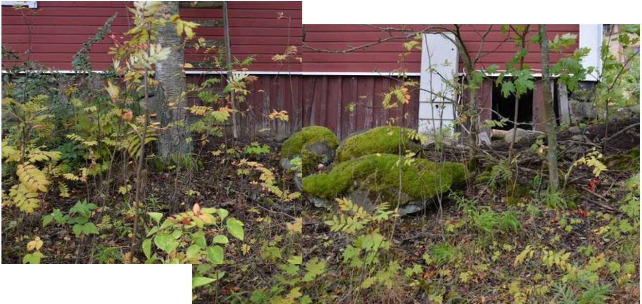
Muuri C (kohta C2) pohjoisesta ja Haulikatu 4:n rakennus.
