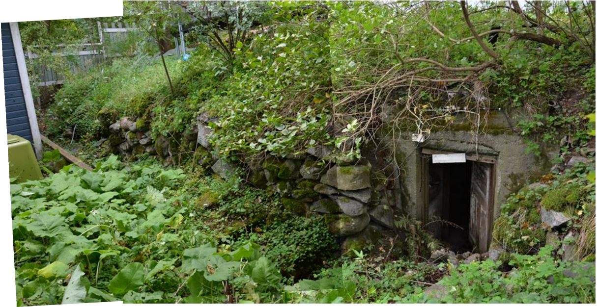
Muuri E ja kellarin sisäänkäynti länsipäädystä. Kuva pohjoisesta.
