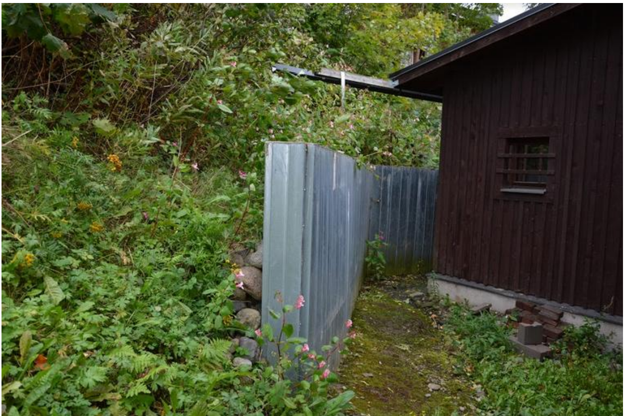
Muuri A, peitetty betonirakenne A8 itäpäässä. Takana näkyy hieman kiviä, mutta ei ole mahdollista tarkastella, minkälainen muuraus kohdassa mahdollisesti on betonin takana.
