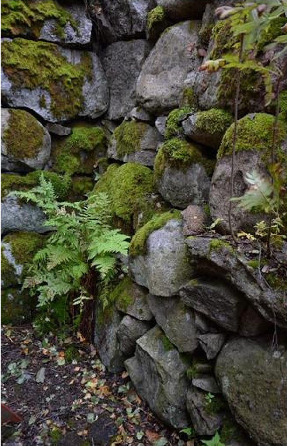
Muuri A (nurkka, jossa kohdat A3 ja A4 kohtaavat. Oikealla kohtaa A3. Pohjoisesta.
