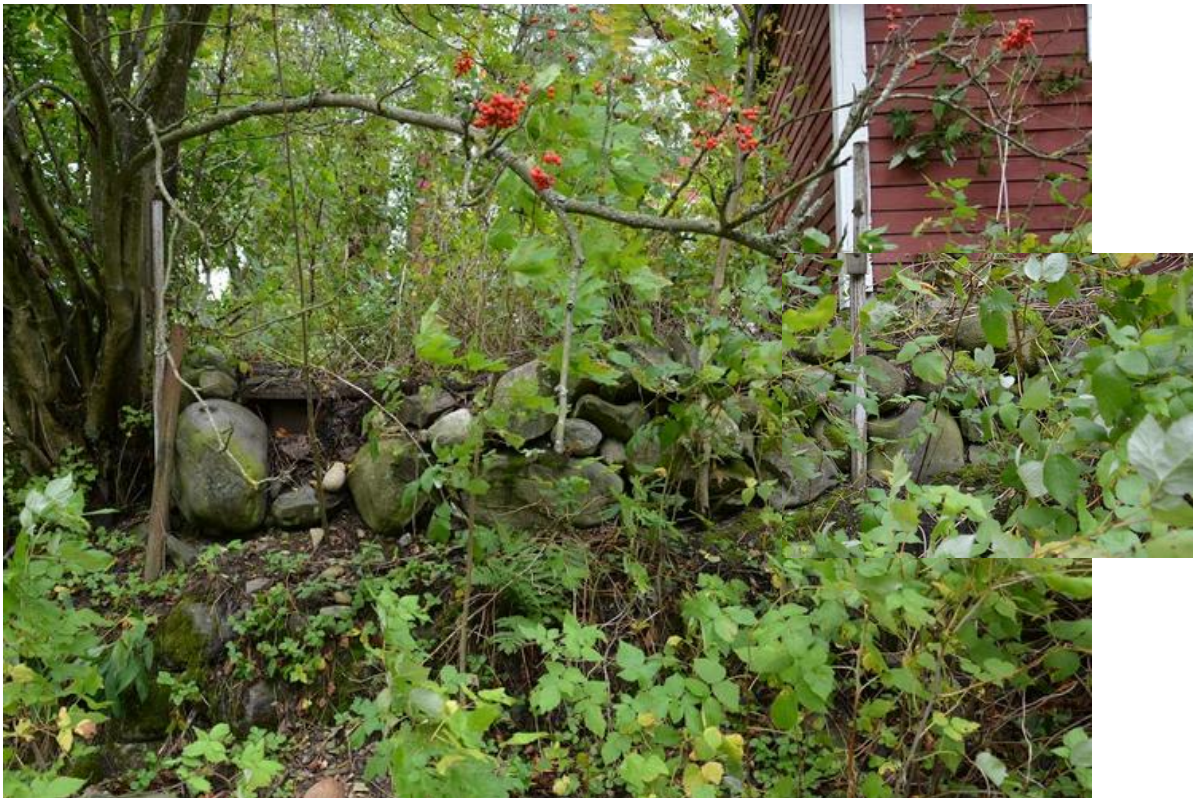
Muuri C (kohta C1, pohjoispääty) lännestä ja Haulikatu 4:n ulkorakennus oikealla.
