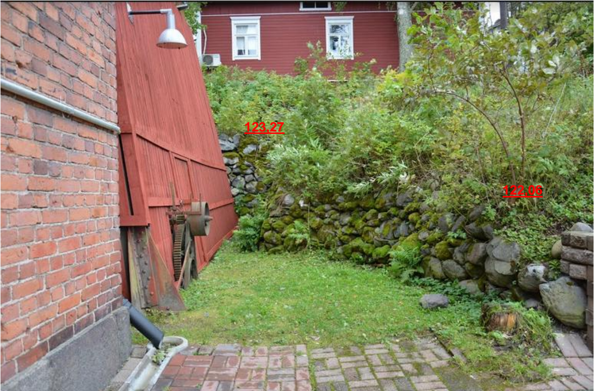
Muuri A (kohta A1) pohjoisesta.
