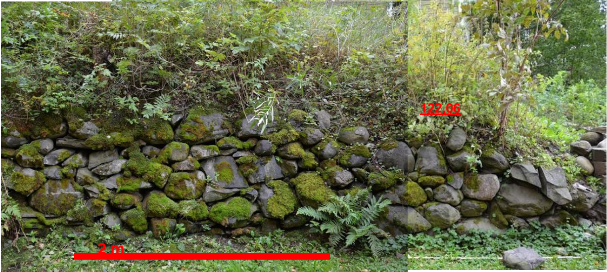
Muuri A (kohta A1) idästä.
