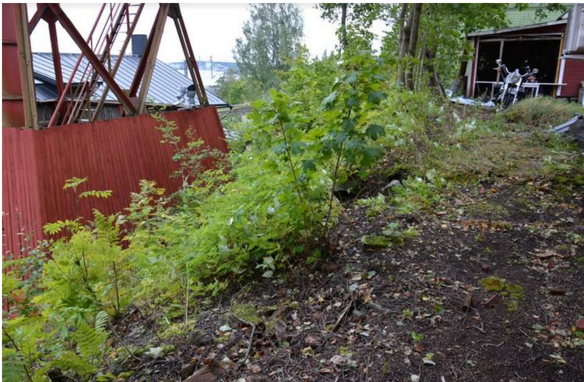
Muuri C (kohta C2) itäpääty, joka erottuu maastossa huonosti lounaasta kuvattuna. Vasemmalla haulitornin aita.
