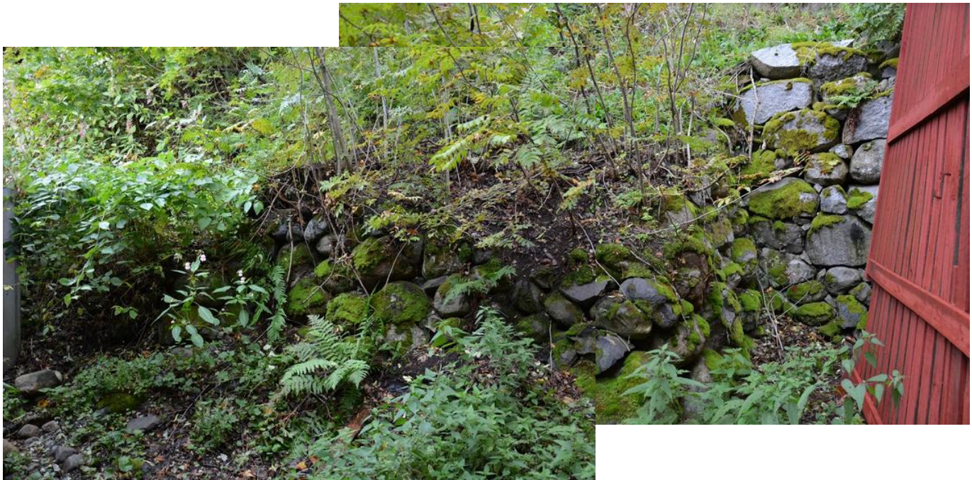
Muuria A. Oikealla muuri A4, nurkan vasemmalla puolella A5, kuvan keskikohdalla muurin nurkka A6 ja sen vasemmalla puolella muurin kohta A7. Vasemmalla betonirakenteen A8 alku. Pohjoisluoteesta.
