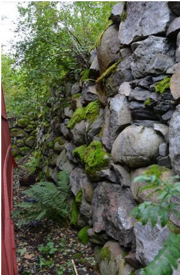
Muuri A, kohta A4, länsipääty lännestä. Muuria ei ollut mahdollista kuvata suoraan edestä tilanpuutteen vuoksi.
