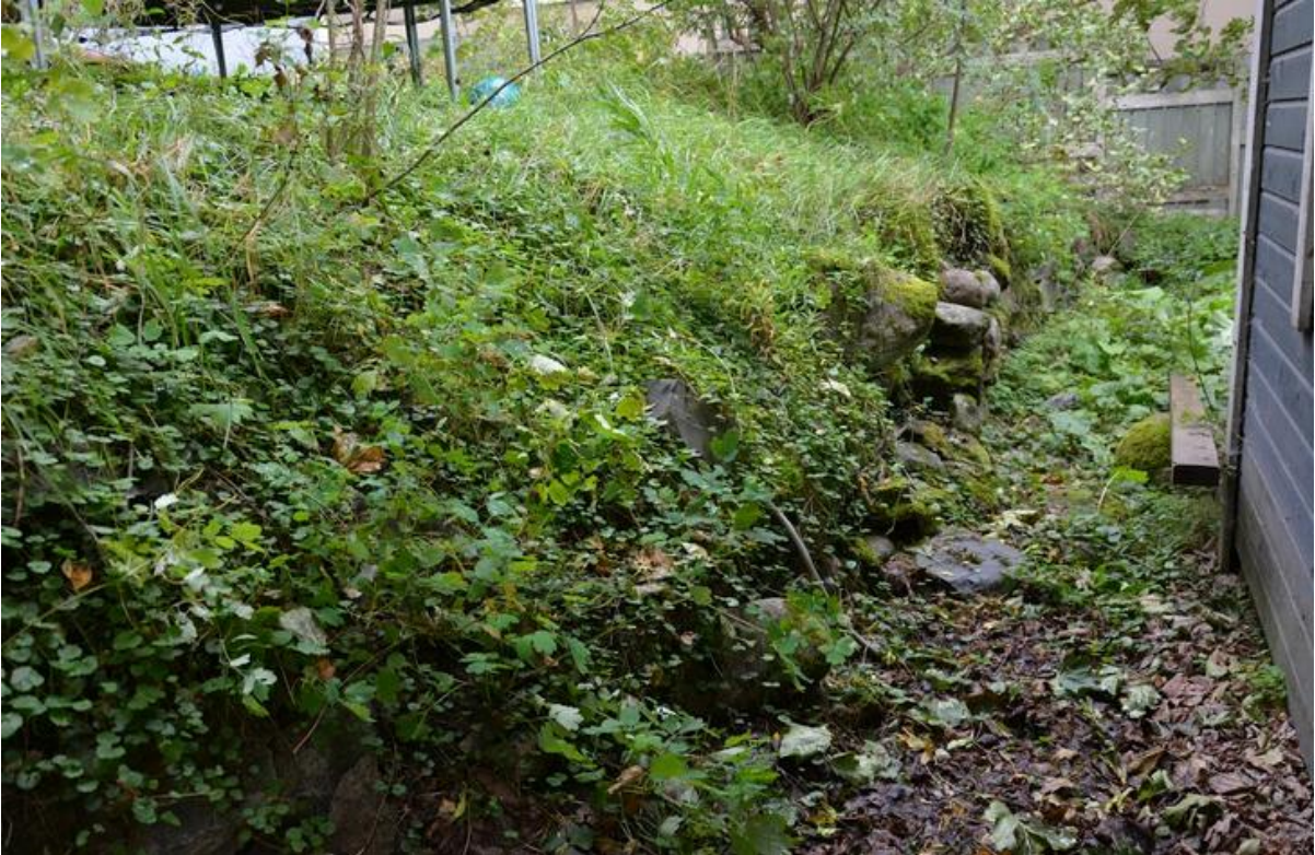
Muuri E, itäpääty. Kuva koillisesta.
