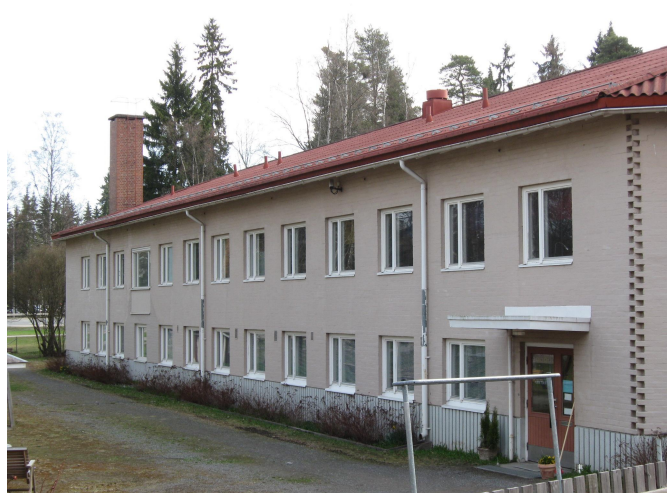
Teiskontien puoleinen seinä eli pohjoissiiven länsipuoli
