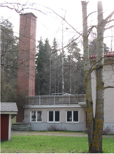
Lämpökeskus torneineen, pohjoispääty
