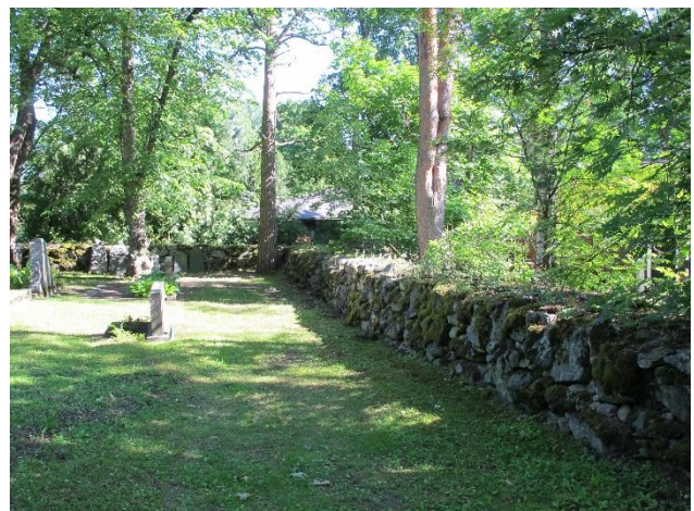
Osasto A koilliskulma, pohjoispäätä ympäröivä kylmämuurattu kivimuri.
