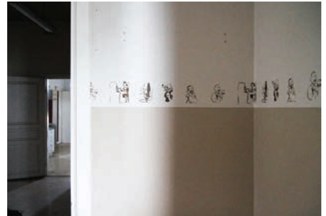
Kuva 76. Seinät: salin seinät ovat peittomaalattua kovaa puukuitulevyä. Salia ympäröi koristeellinen painokuvio.
