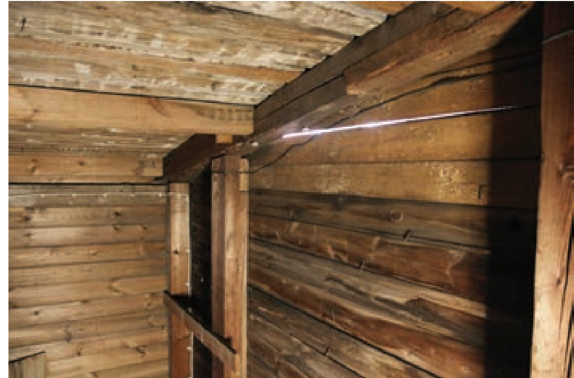
Kuva 172. Ullakon porrashuoneessa hirsirakenteet näkyvissä.
