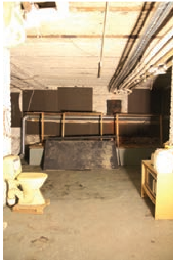
Kuva 126. Katto maalattua betonia.
