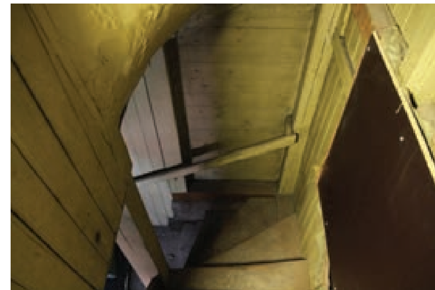
Kuva 166. Porrashuone, josta kulku rakennuksen sisäpihalle.
