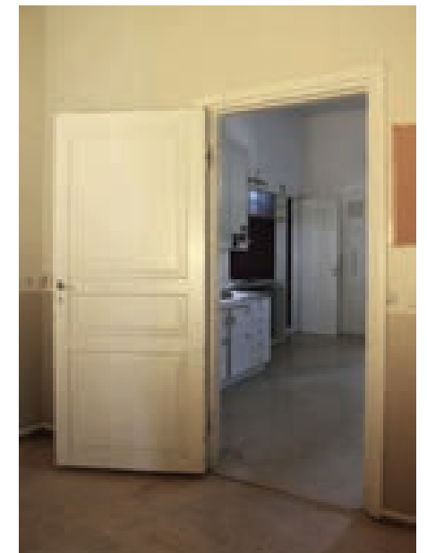
Kuva 47. Eteisen ja keittiön välissä peittomaalattu peiliovi.
