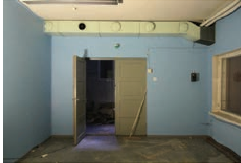
Kuva 119. Peittomaalatut peilipariovet. Seinät peittomaalattua kovaa puukuitulevyä/ maalattua tasoitetta.
