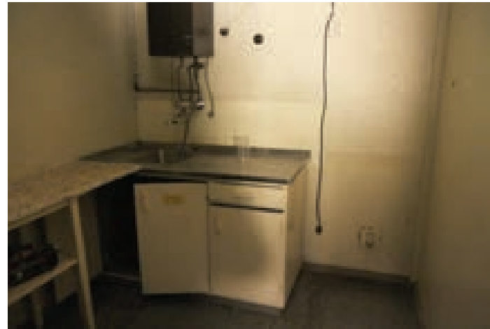
Kuva 116. Keittiökalusteet peittomaalattua puuta.
