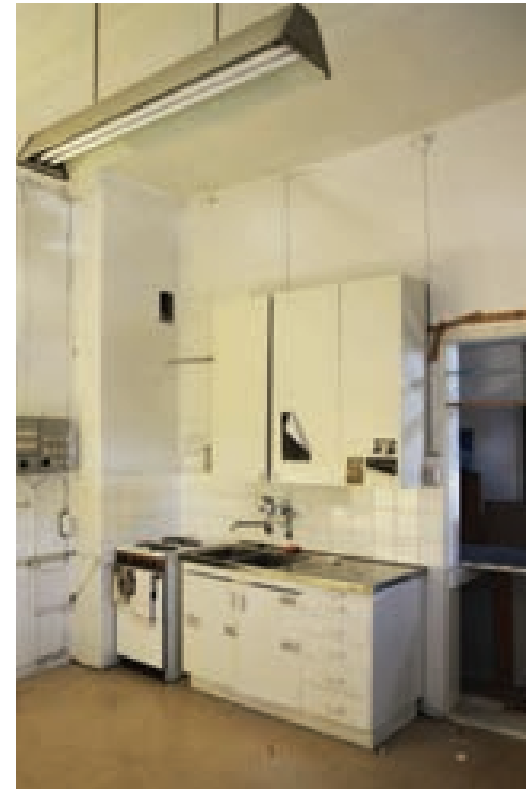
Kuva 57. Keittiön kalusteet peittomaalattua puuta.
