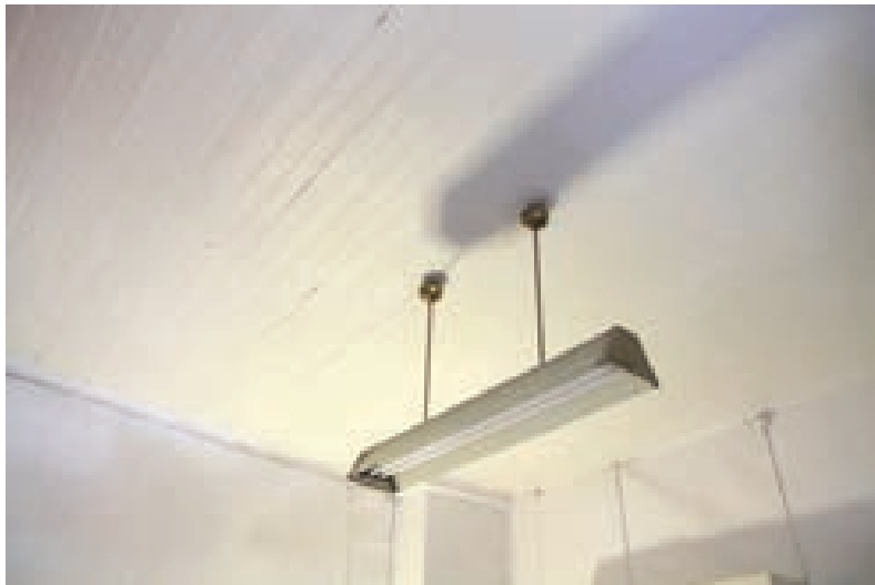
Kuva 55. Katto peittomaalattua helmiponttipaneelia.
