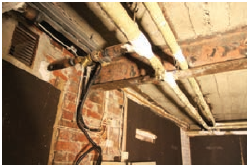
Kuva 125. Rakenteelliset i-palkit.
