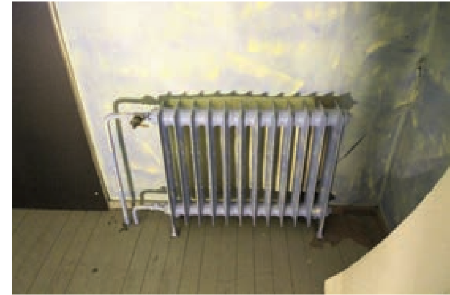
Kuva 94. Lattiat peittomaalattua puuta. Pukutilassa ripapatteri.
