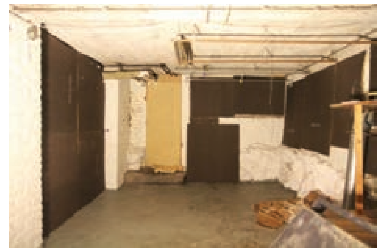
Kuva 128. Ikkunoita levytetty umpen.
