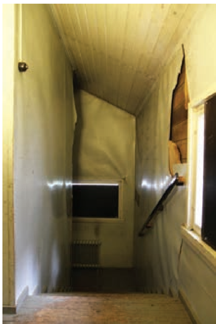
Kuva 103. Näkymä portaan ylätyasanteelta. Seinissä peittomaalattu kova puukuitulevy.
