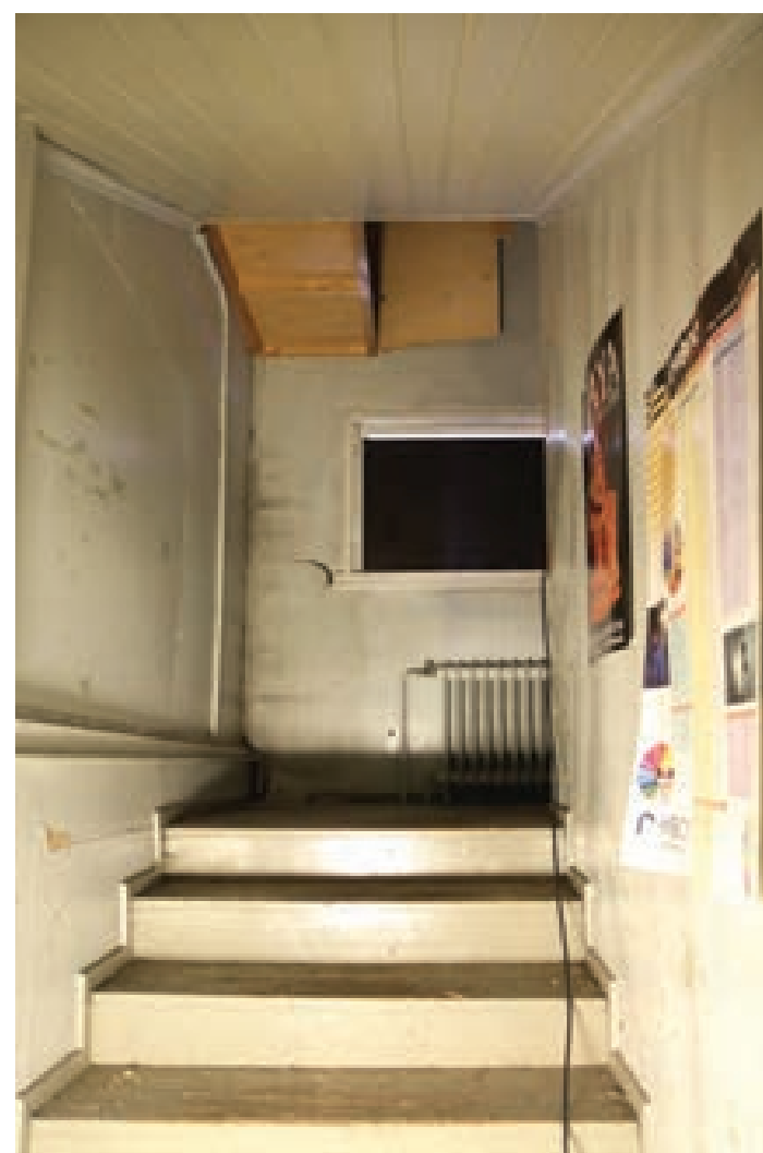
Kuva 105. Portaat peittomaalattua puuta.
