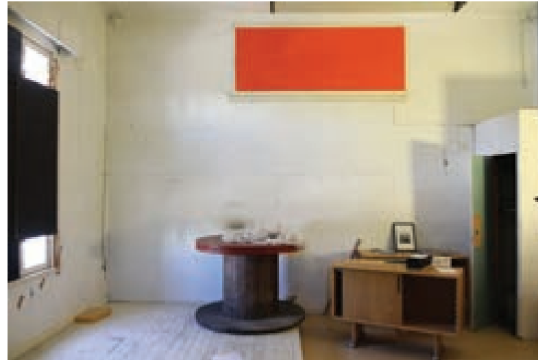
Kuva 52. Keittiön ikkunat levytetty umpeen.
