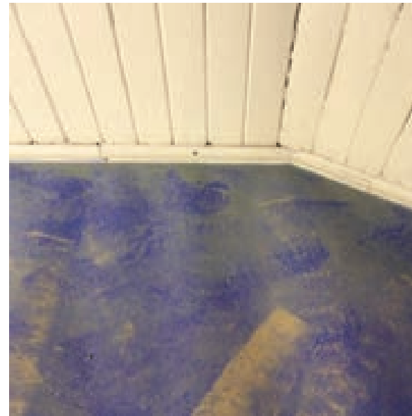
Kuva 92. Pukutilan katto peittomaalattua paneelia.
