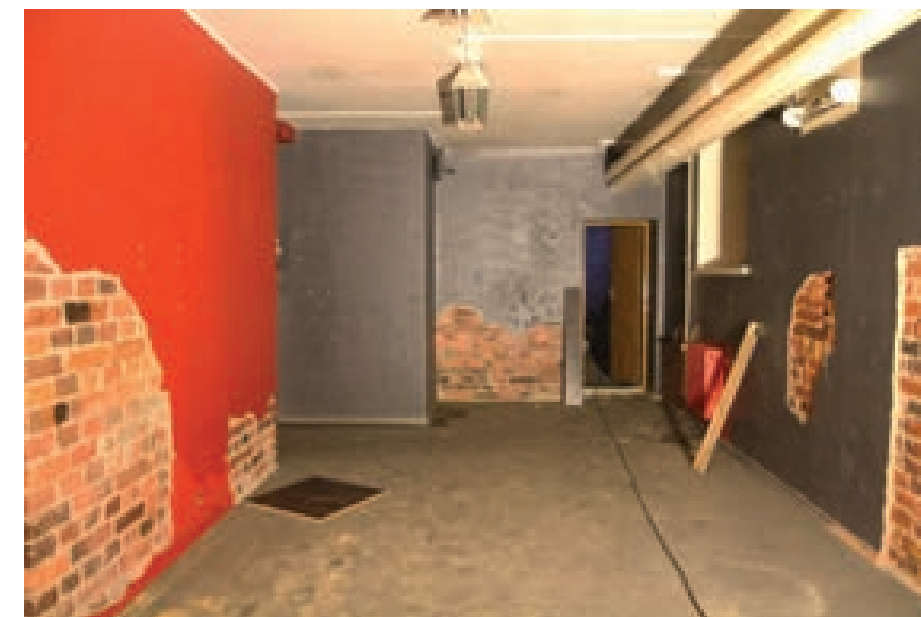
Kuva 146. Seinissä peittomaalattu tasoite.
