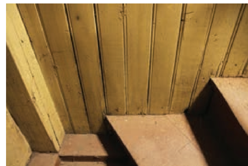
Kuva 168. Portaat peittomaalattua puuta.
