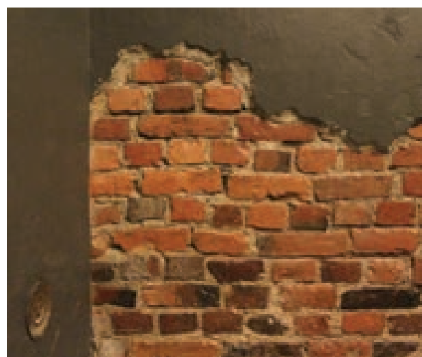
Kuva 147. Tasoitteen alta näkyy tiiliseinää.
