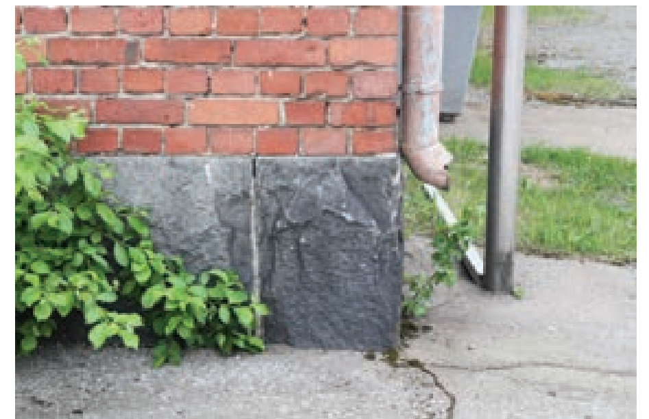
Kuva 14. Pohjoispäädyn graniitti-punatiilisokkeli.
