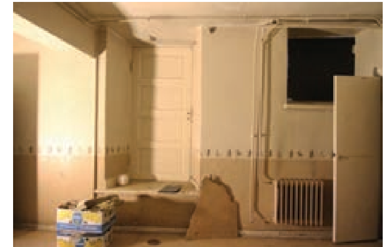
Kuva 151. Aulan värimaalilma linjassa yläkerran salin ja eteisen kanssa. Peittomaalattu peiliovi. Ovesta kulku sisäpihalle johtavaan porrashuoneen varastotilaan.
