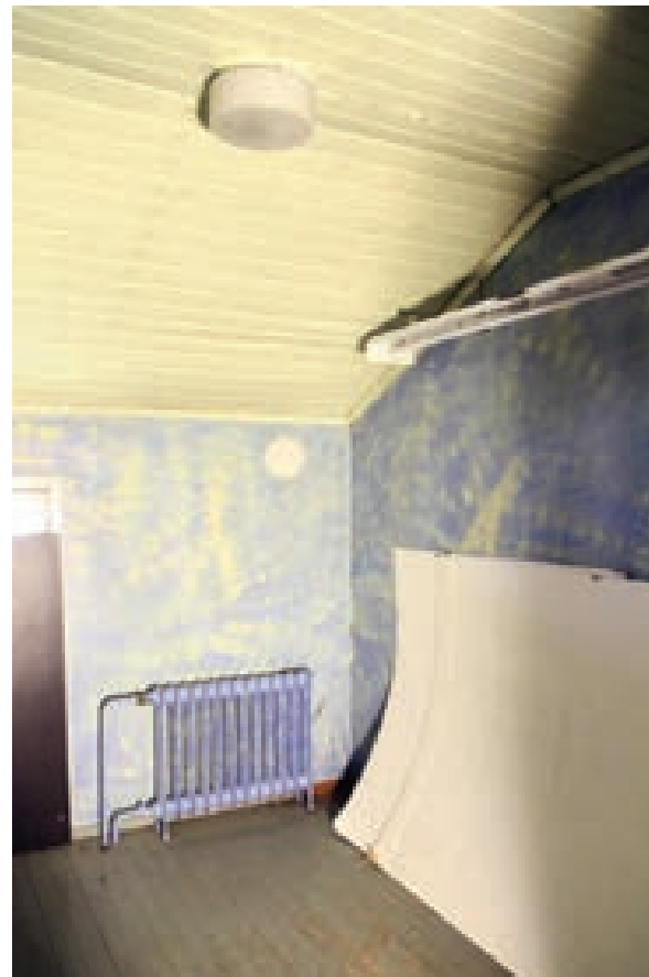
Kuva 93. Seinissä kova puukuitulevy, jossa kuviollinen peittomaalipinta.
