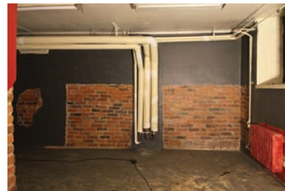
Kuva 149. Peittomaalattut ripapatterit.
