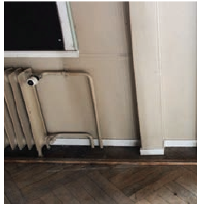
Kuva 75. Salissa ripapatterit.
