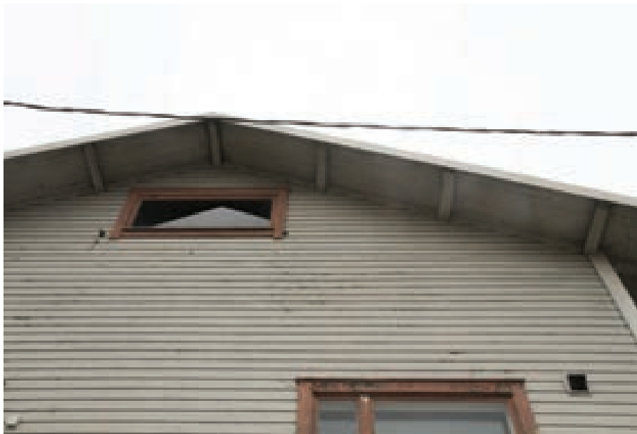
Kuva 12. Pohjoispäädyn ikkunat. Rakennuksen ikkunat on uusittu 60-luvulla.
