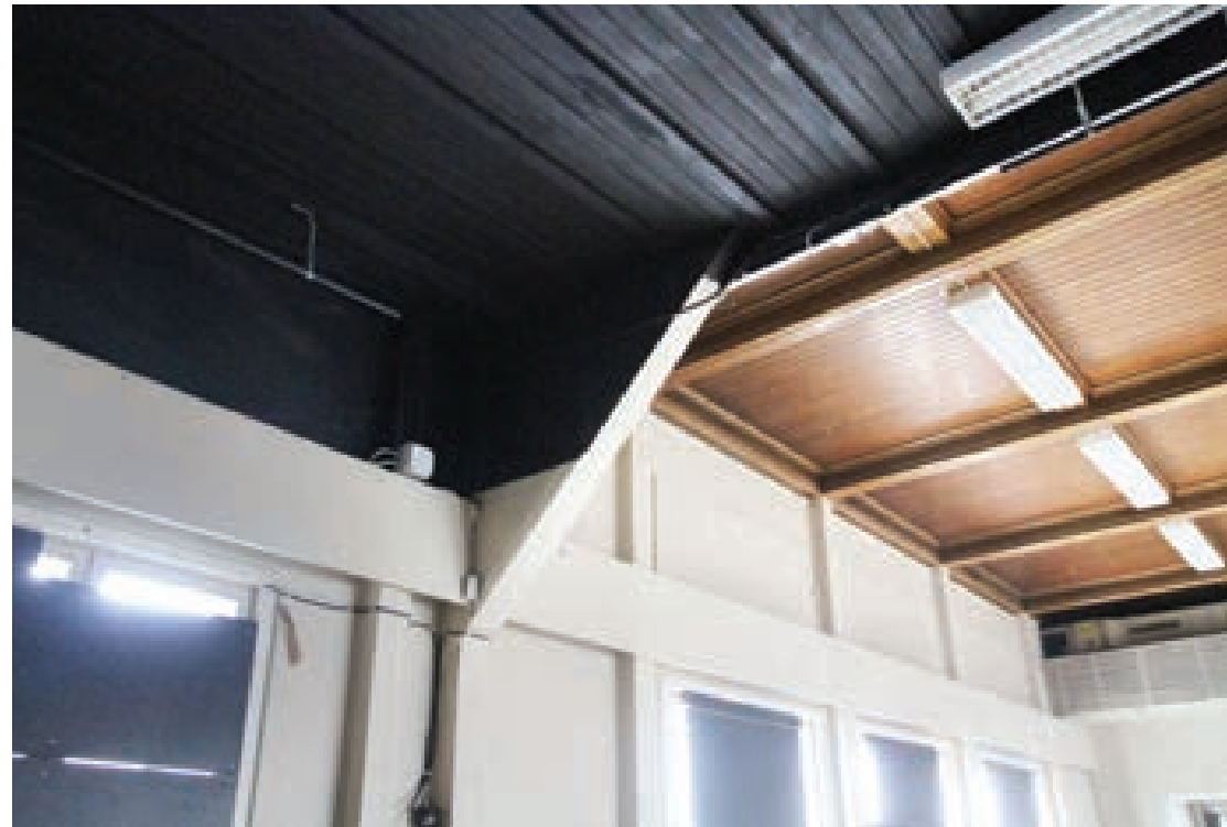
Kuva 73. Salin näyttämön puoleinen katto peittomaalattu mustalla mattavärillä.
