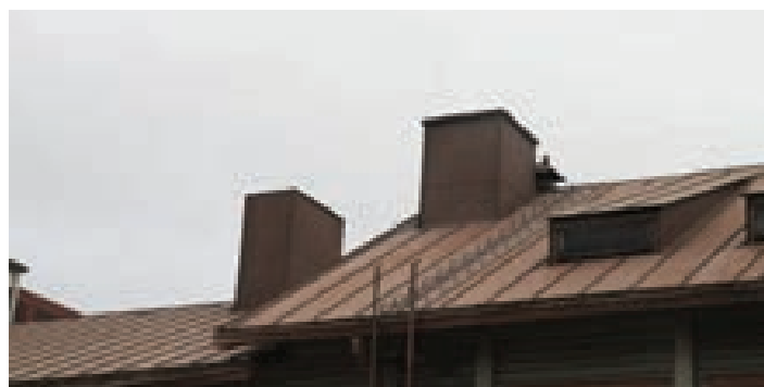
Kuva 29. Harjakatto saumattua peittomaalattua peltikatetta. Piiput pellitetty.
