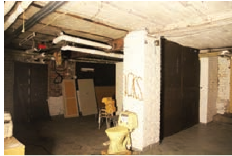
Kuva 122. Lattia maalattua betonia.
