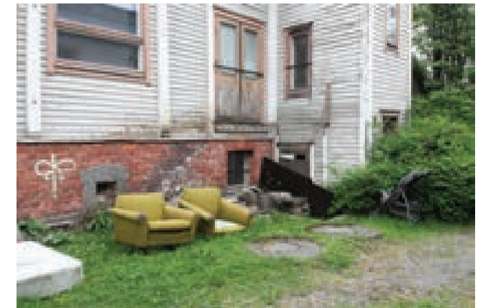
Kuva 21. Sisäpihanäkymä. Pohjoispäädyn ulkoneva porrashuone.
