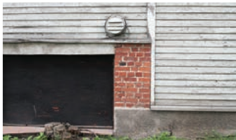
Kuva 25. Eteläpään ikkunat levytetty umpeen.
