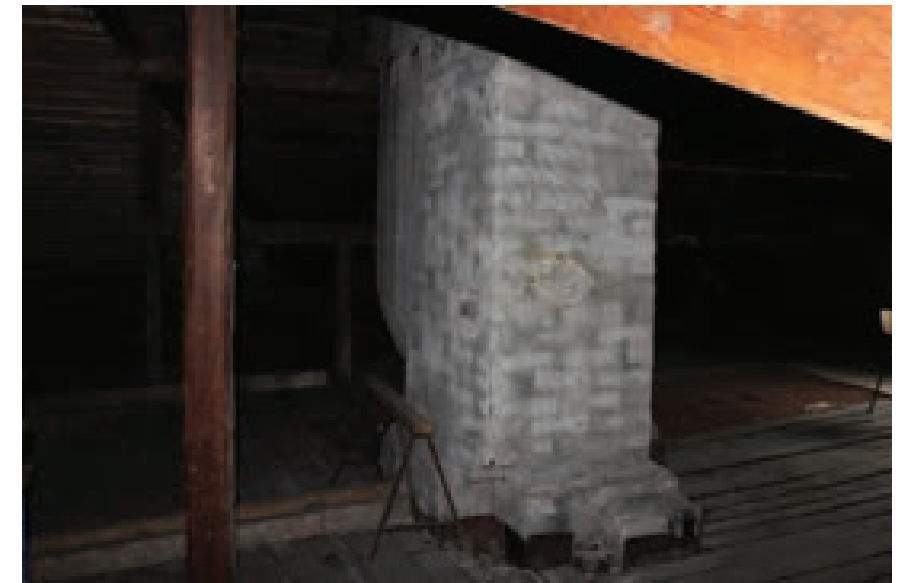
Kuva 183. Muurattu savupiippu.
