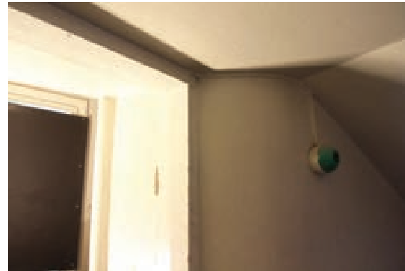
Kuva 160. Ikkunat levytetty umpeen.
