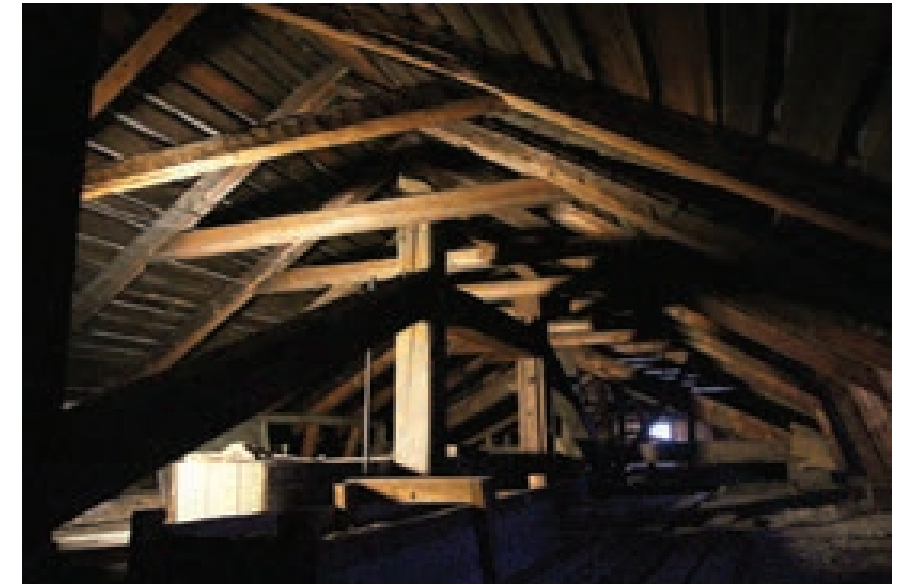
Kuva 181. Kattotuolit hirrestä.
