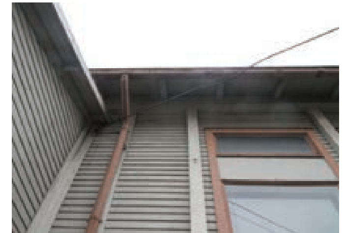
Kuva 22. Rakennuksessa kantikkaat vaakakourut.
