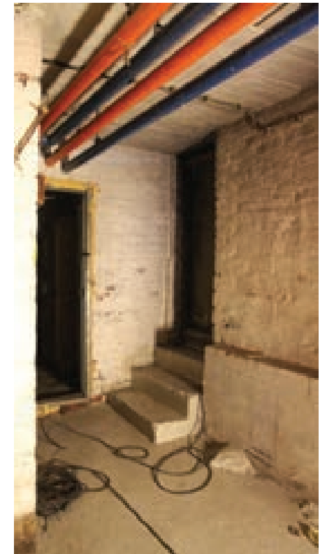
Kuva 136. Sisäänkäynti Tavara-aseman puolelta.
