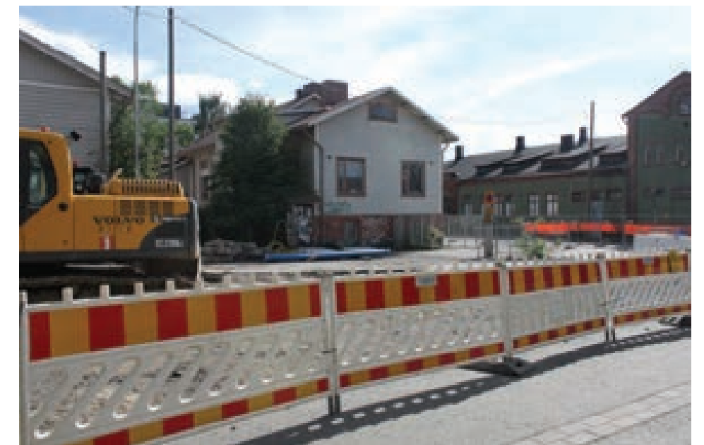
Kuva 41. Morkun pohjoispääty. Rakennuksen pääsisäänkäynti pohjoispäädyn vasemmalla puolella.
