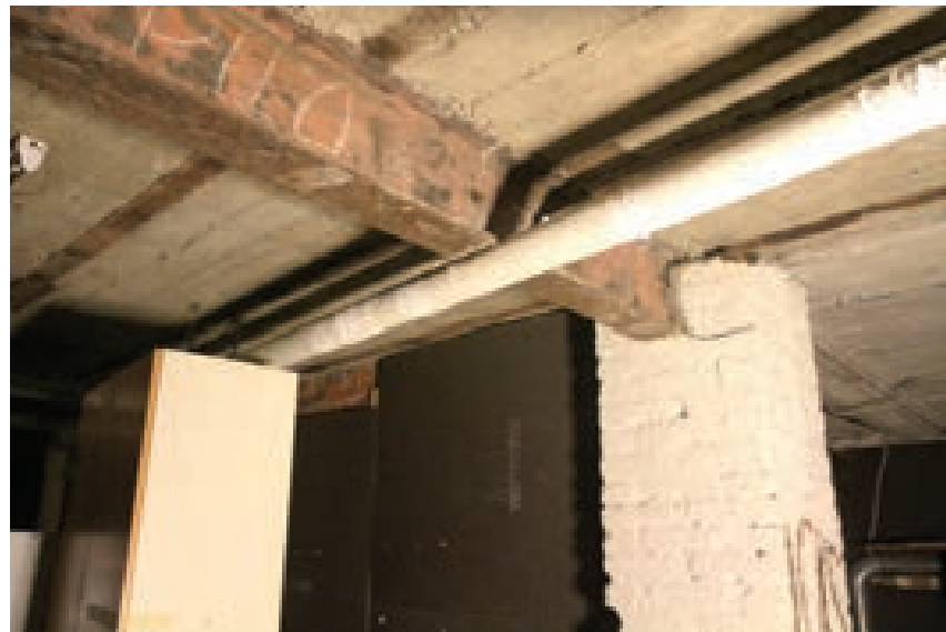
Kuva 124. Osa seinistä ja pilareista on peittomaalattua tiiltä.
