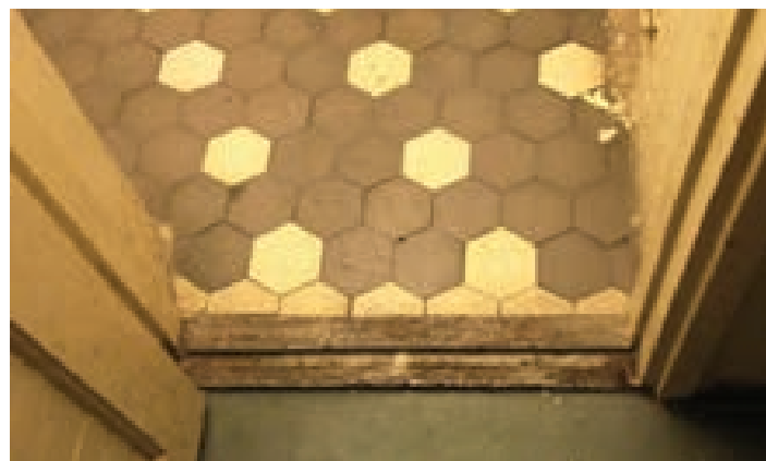
Kuva 141. Lattiassa valko- ja ruskeasävyinen kuusikulmainen klinkkeri.
