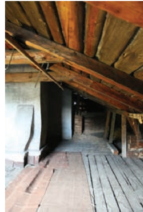
Kuva 178. Näkymä ullakon eteläpäättyyn.
