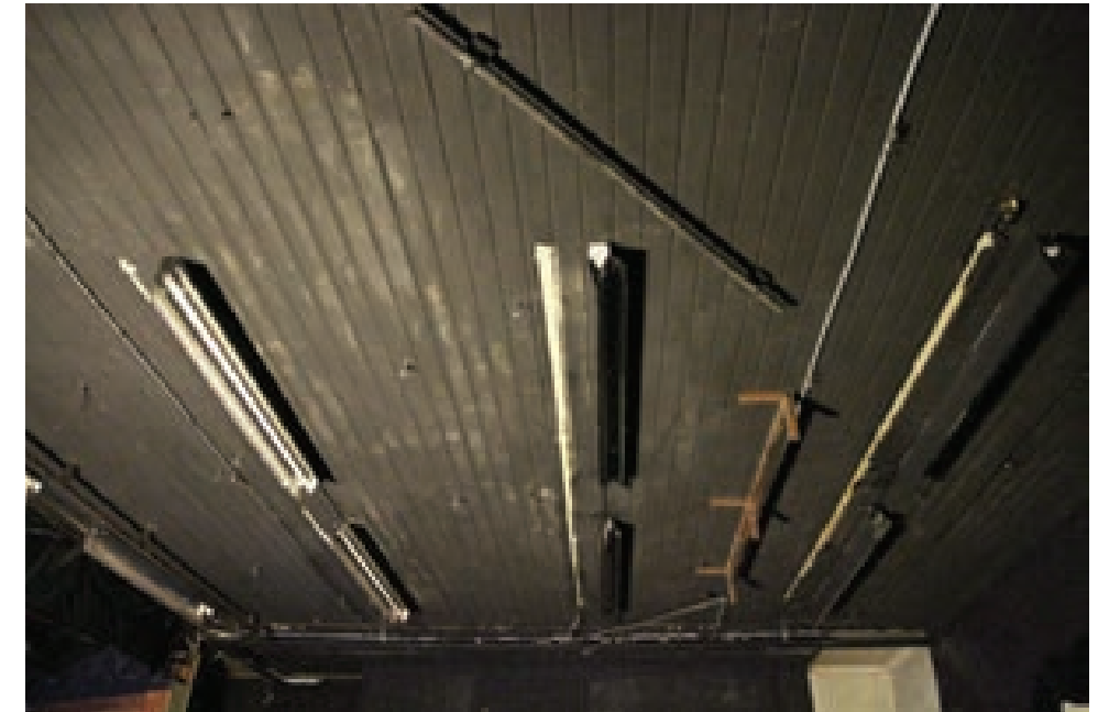
Kuva 88. Näyttämön katossa erilaisia kiskoja lavasteita varten.
