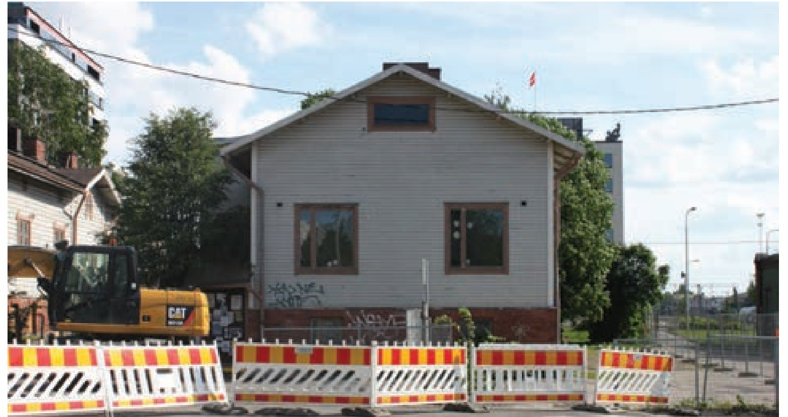
Kuva 11. Julkisivu pohjoiseen. Vasemmalla puolella rakennuksen pääsisäänkäynti.
