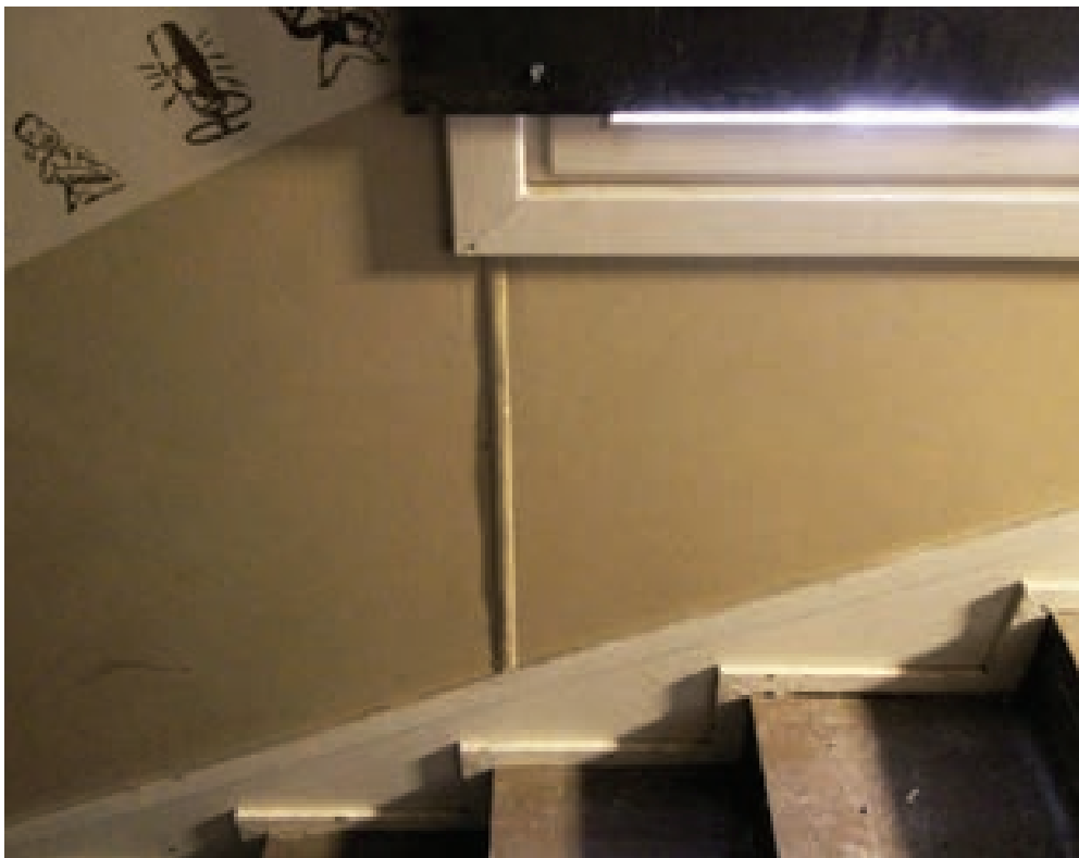
Kuva 162. seinät peittomaalattua kovaa puukuitulevyä.
