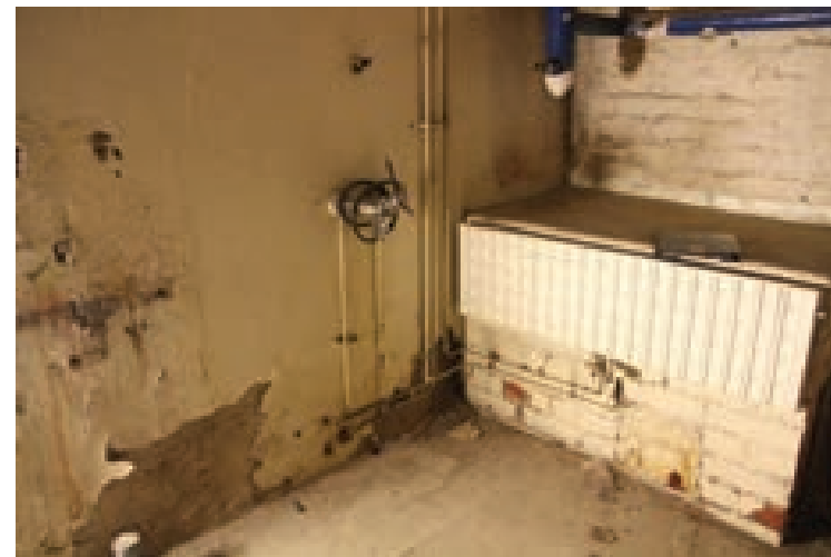
Kuva 135. Seinät peittomaalattua betonia ja tiiltä.
