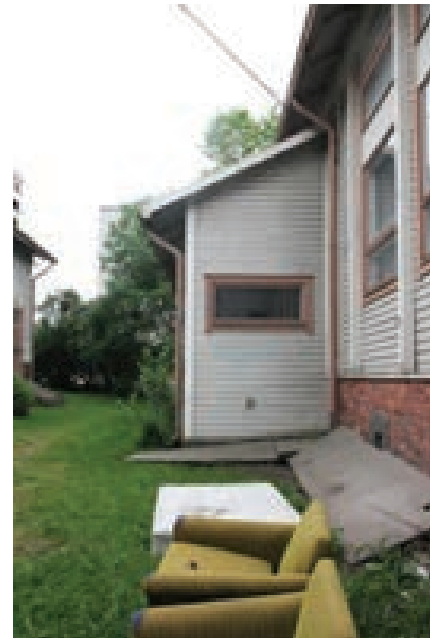
Kuva 18. Kuvassa eteläpäädyn ulkoneva porrashuone.
