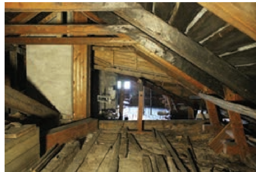
Kuva 177. Näkymä ullakon keskeltä rakennuksen pohjoispäättyyn.
