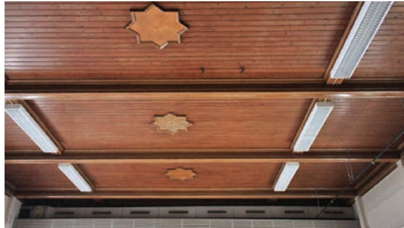
Kuva 74. Puunvärinen katto on kuultomaalattua helmiponttipaneelia. Katossa on myös koristeelliset tähdet ja näkyvät ootratut kattopalkit.
