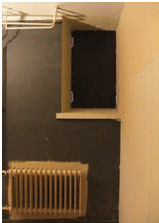
Kuva 152. Ripapatterit.
