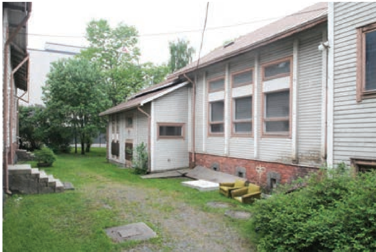
Kuva 16a. Julkisivu itään
