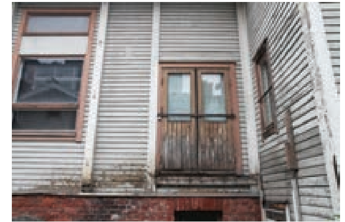
Kuva 20. Ulko-ovet lasiaukollisia peittomaalattuja pystypaneloituja ovia. Oven alta purettu ulkoporras pihalle.
