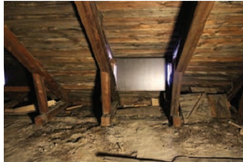
Kuva 174. Kattolyhdyn ikkuna sisäpuolelta levytetty umpeen.
