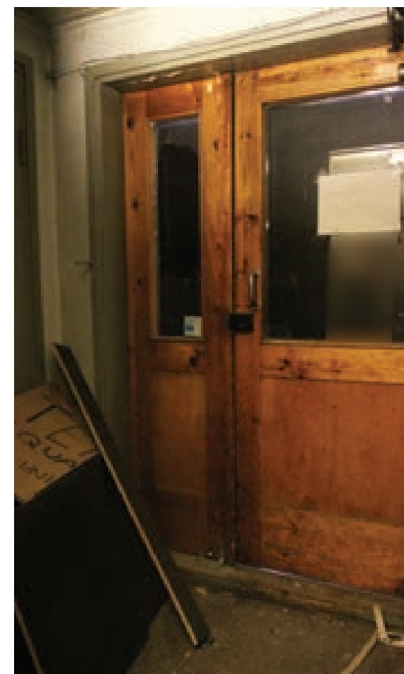
Kuva 114. Ulko-ovi sisäpihalle: lasiaukollinen epäsymmetrinen paripuuovi.
