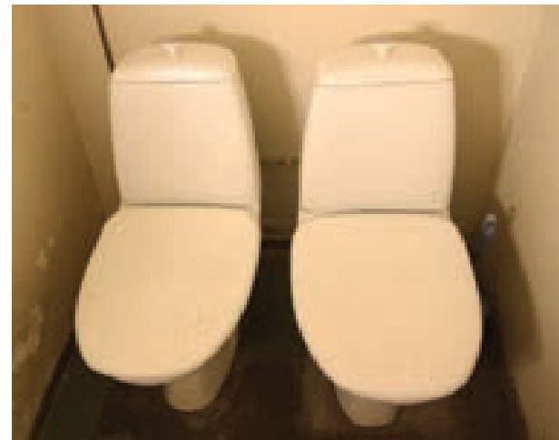
Kuva 137. Naisten WC, tilassa kaksi wc-istuinta.
