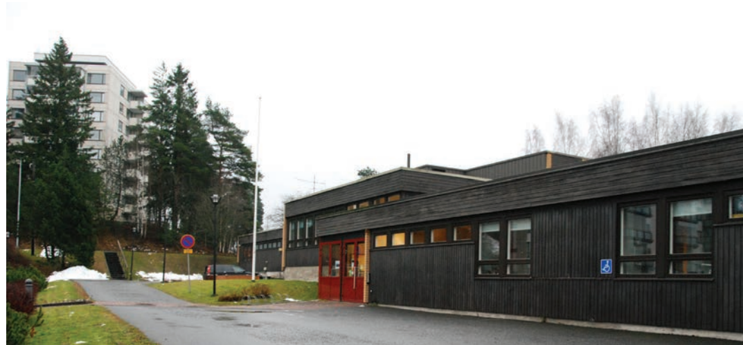
Rakennuksen pääsisäänkäynti ja julkisivu pohjoiseen.
