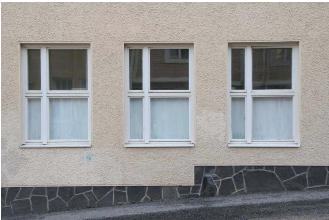
Kuva 2. Alkuperäinen ikkunatyyppe ja liuskekivisokkeli
