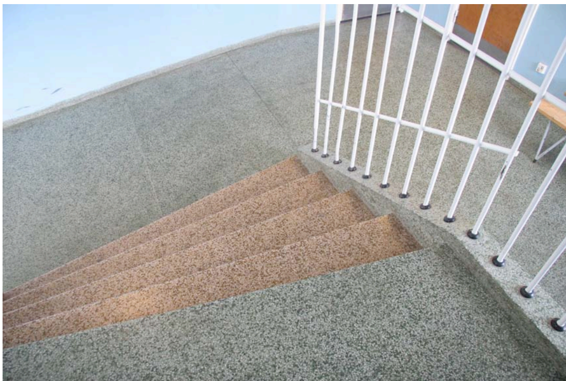
Kuva 19. Portaan mosaiikkibetonia. Porraskelmat on tehty eri värillä kuin porrastasanteet
