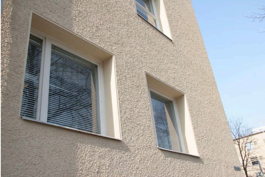
Kuva 1. Katujulkisivun sisäänvedetty ikkuna
