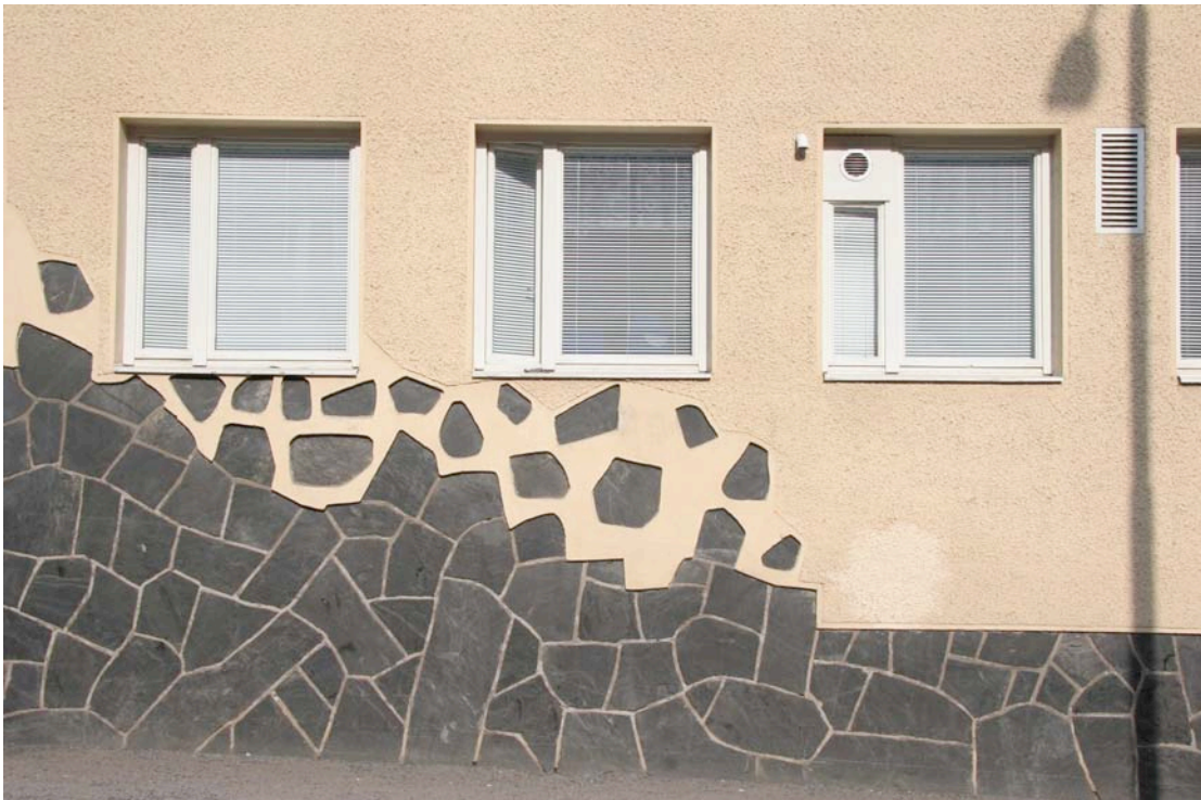
Kuva 6. Kivimuurin ”laskeutumsidetalji” sokkeliksi Satakunnankadun puolella
