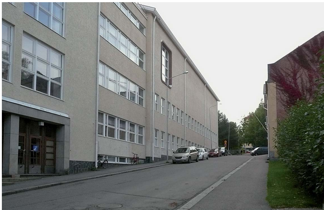
Suokadun puoleinen juhlasipi ja sisäänkäynti, Marjut Lund.
