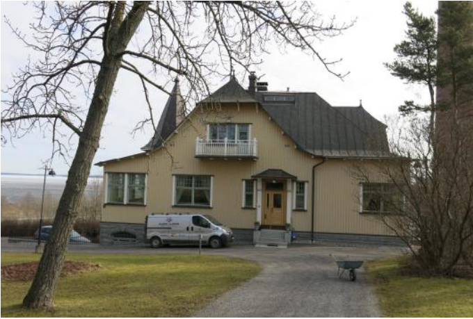
Lavoniuksen talon lounaissivu 2000-luvun peruskorjauksen jälkeen. Länsikulman parveke on katettu ja muutettu asuintilaksi, parveke on saanut keveämmän kaitteen ja ullakkokerroksen ikkunalaajennus on purettu. Kuva: Miia Hinnerichsen, Pirkanmaan maakuntamuseo 2016.
