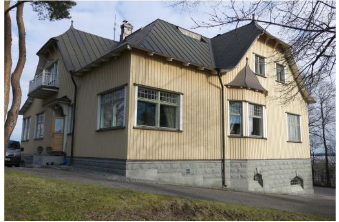
Lavoniuksen talon eteläkulma 2000-luvun peruskorjauksen jälkeen. Sokkelin materiaali on vaihtunut punatiilestä harmaaksi graniitiksi. Kuva: Miia Hinnerichsen, Pirkanmaan maakuntamuseo 2016.
