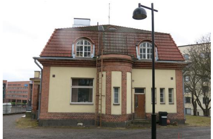
Villa Sandsund, pohjoissivu. Alkujaan palvelusväen käyttämä keittiön ovi sekä suurempi keittiön ikkuna on vaihdettu todennäköisesti 1950-luvulla. Kuva: Miia Hinnerichsen, Pirkanmaan maakuntamuseo 2016.
