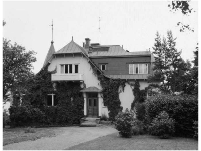
Lavoniuksen talo lounaasta 1990. Julkisivuihin on vaihdettu pystyrimalaudoitus. Kuva: Ilpo Peuhkuri, Vapriikin kuva-arkisto.
