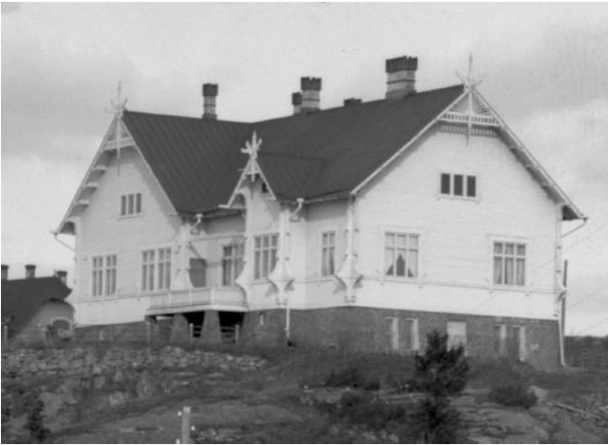
Ryselinin talo idästä pian valmistumisensa jälkeen. Huvilan luoteissivulla itäpäädyn poikittaisen rakennusosan ja pienen ulkonevan poikkipäädyn välissä on parveke.
