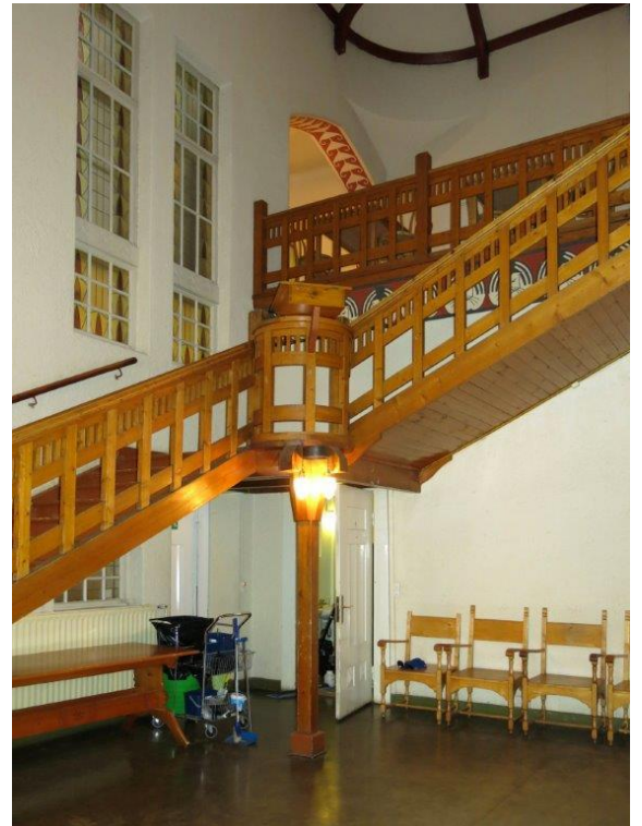
Hallista toiseen kerrokseen johtavat portaat (porras B), porrastasanteen puhujan paikka ja lyijylasi-ikkunat porrashuoneeseen (porras A).
