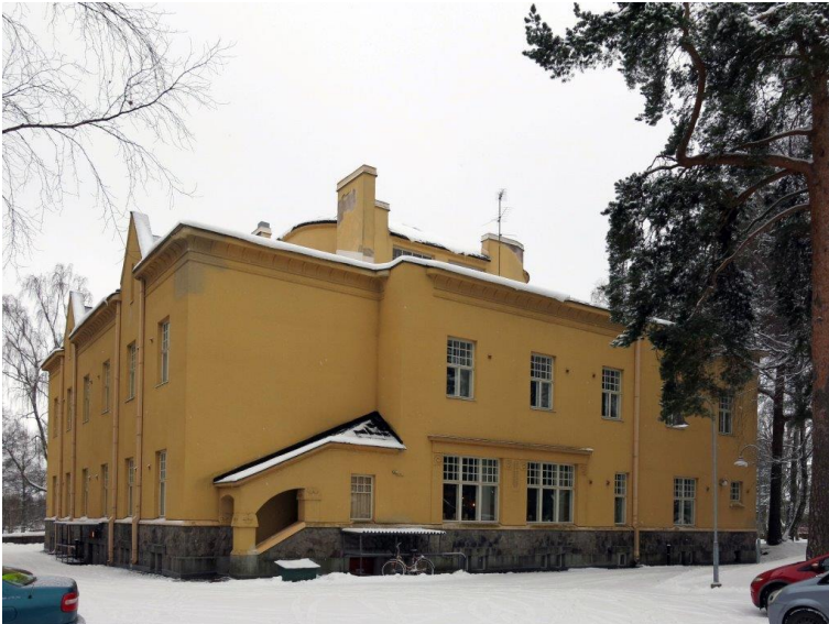
Pohjoissivu. Koristeaihe tai -kaide julkisivun yläosasta on jätetty toteuttamatta.
