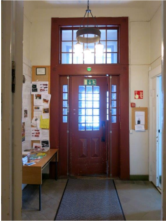
Pääovi tuulikaapista eteiseen (104).
