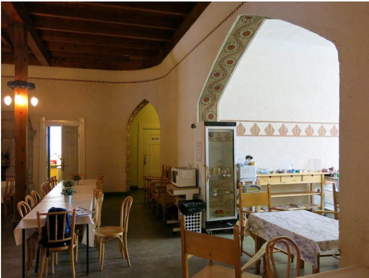
Yleiskuva suuresta oleskeluhallista (101). Seinien yläosissa kiertää ohut maalauskoristelu, oviaukoissa ja hallien eteläosassa on leveämmät maalauskoristelut. Maalaukset on otettu esiin tai uudelleenmaalattu 1980-luvun peruskorjauksen yhteydessä.
