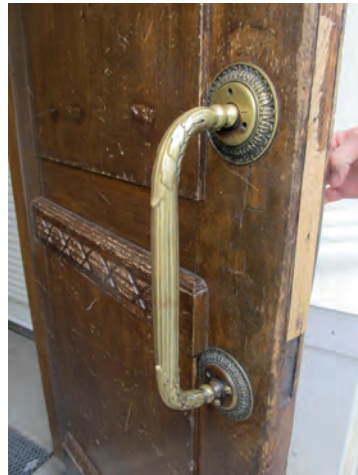
Pääoven ulko-oven vedin.
