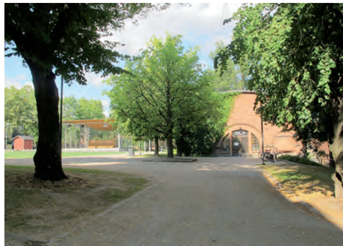
Frenckellin vanhassa kattilahuoneessa sijaitsee vielä kirjaston sanomalehtilukusali. Taustalla on Laikun esiintymislava. Lavan nimessä näkyy tamperelaisten vanha kaupunginkirjaston kutsumanimi: Laikku.
