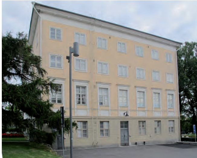
Julkisivu Tampereen Teatterin suuntaan.
