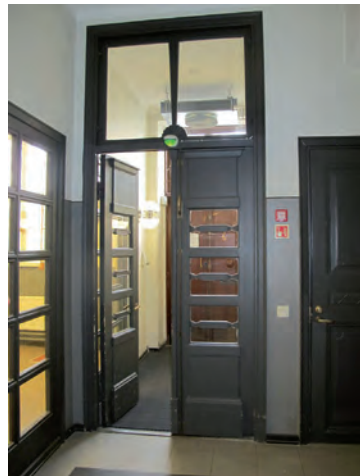
1. kerroksen tuulikaapin lasiovi.
