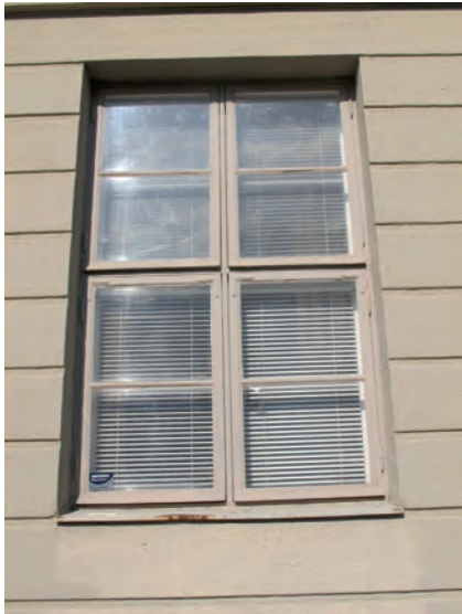
Ikkunat ovat alkuperäisiä. Ne ovat kunnostettavissa.
