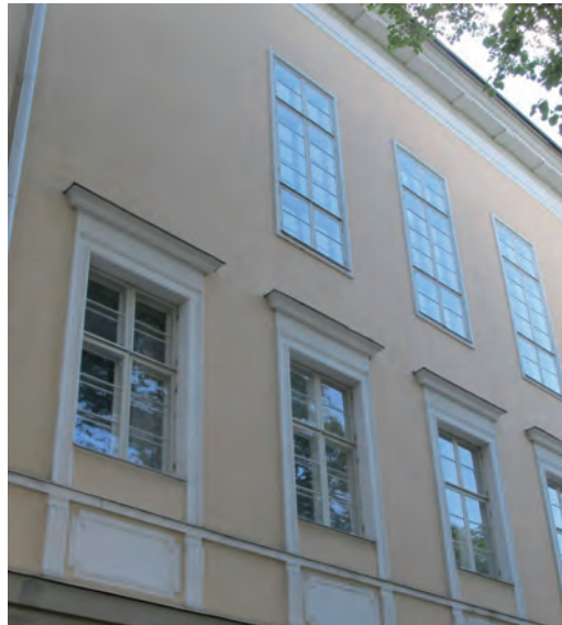
Pääkerroksen kehystetyt ikkunat on asennettu syvennyksiin, valtuuston istuntosalin suuret ikkunat on asennettu julkisivun kanssa samaan linjaan.
