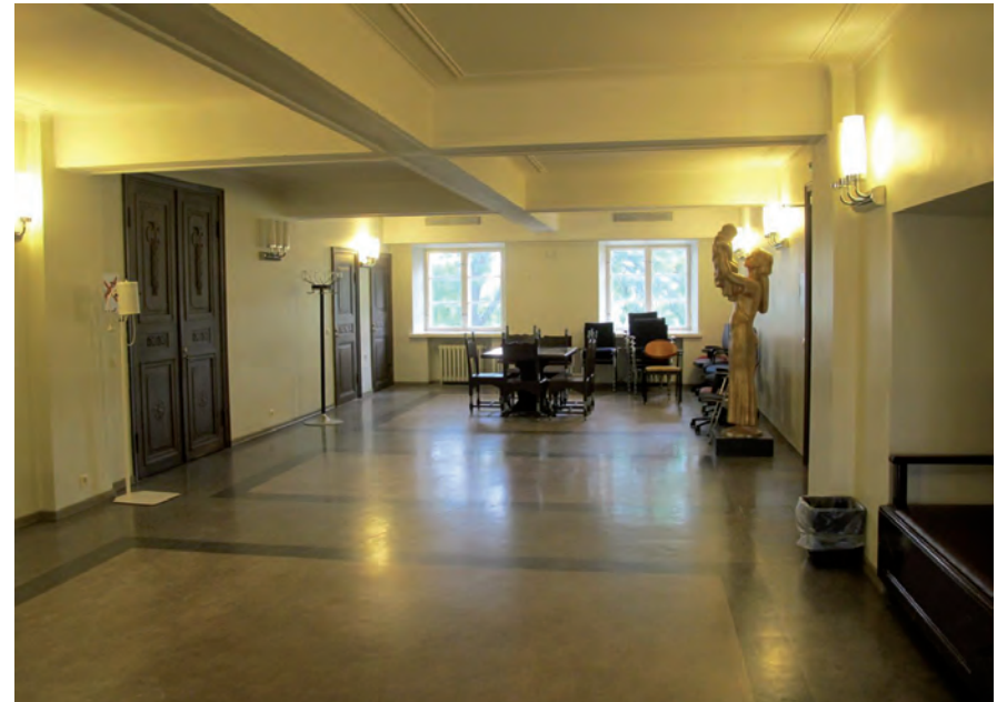
3. kerroksen aula palautettiin alkuperäiseen muotoonsa vuonna 1988. Ikkunoiden yläpuolelle tehtiin kotelointi ilmastointiputkille.
