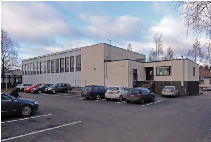
Saukkolan eteläjulkisivu, rakennus 15.
