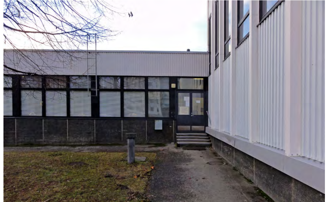
Saukkolan eteläjulkisivussa on käytetty 1960-luvun arkkitehtuurille tyypillistä alumiinipeltiä.
