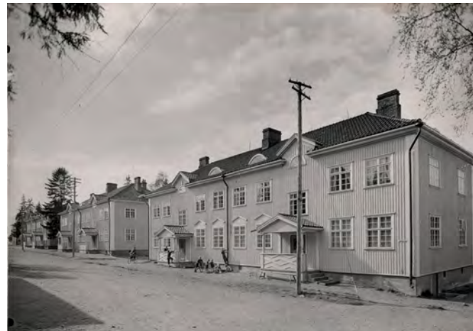
Arkkitehti Birger Federleyn suunnittelemia kaksikerroksisia puisia työväenasuntoja Omakadun varrella. Kuva E. M. Staf 1950. Tampere-Seuran kuva-arkisto.
