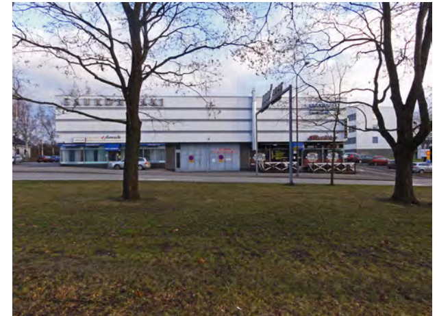
Saukonmäen liikekeskuksen länsijulkisivu, rakennus 11
