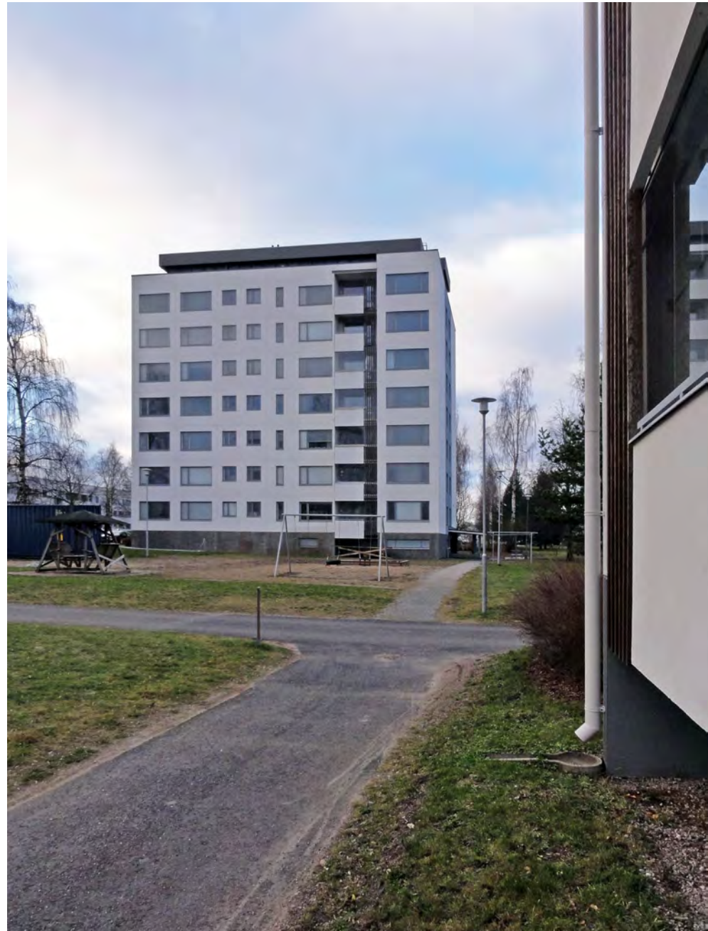
Asunto Oy Saukonpesä, rakennus 7.
