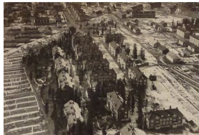
Ilmakuva Saukonmäen vanhasta puutaloalueesta vuodelta 1930. Vasemmassa yläkulmassa Ludekylän talot. Tampere-Seuran kuva-arkisto.
