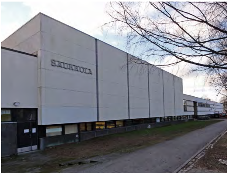
Saukkolan pohjoisjulkisivu, rakennus 15.
