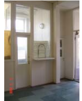
Sivulla ja alla: Konttorin aulatilat ovat säilyneet alkuperäisessä asussaan. Vanhaa kalustusta ovat mm. seinäkello, opaailiasiriippuvalaisimet, valkoiseksi maalattu huokoinen, akustoiva rei'itetty puukuitulevy sisäkatoissa, kvartsivinyyliaattalattia ja puurunkoiset huoneiden lasiväliseinät.
