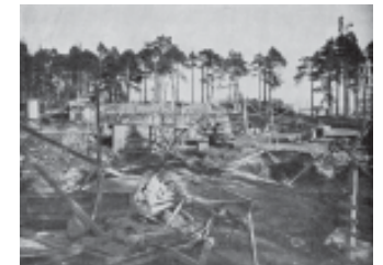
Yllä: Rakennustyömaa vuonna 1953 Alla: Tehdassali (Kuvälähde: Urbans)
