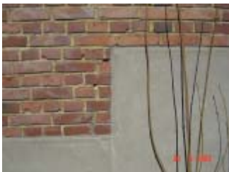
Tiilimuurauksen liittyminen sileäksi rapattuun betonisokkelin
