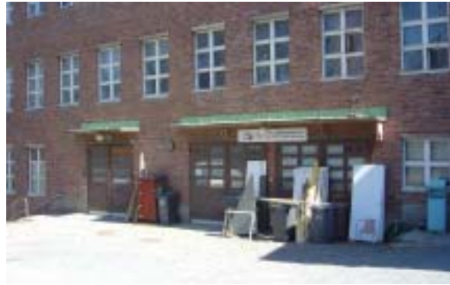
Ulokkeena valettuja teräsbetonikatoksia tehtaan länsisivulla
