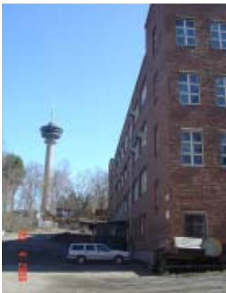
Tehtaan pohjoissivu länsisuunnasta, taustalla Näsinneula
