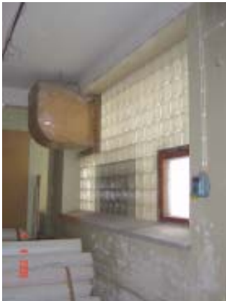
Tuloilmakanavien raitisilmaventtiilit julkisivussa ja sisätilassa.
