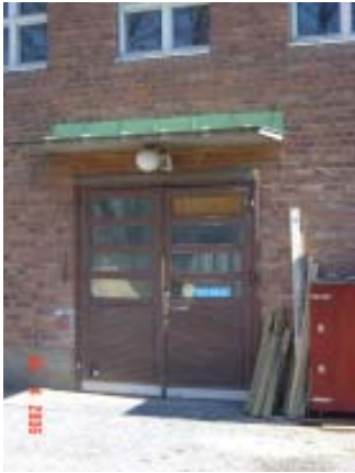
Ulokkeena valettuja teräsbetonikatoksia tehtaan länsisivulla
