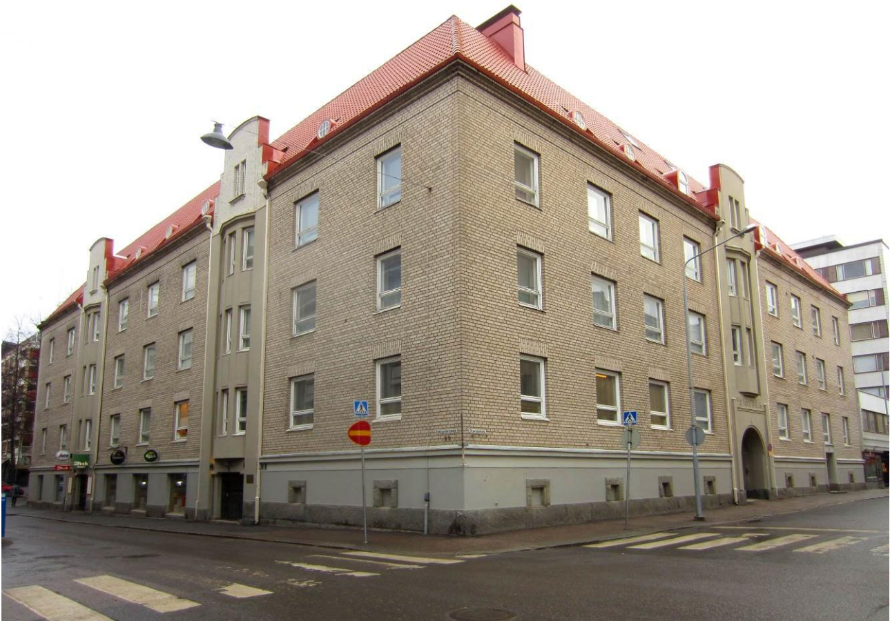
Näkymä Aleksanterinkadun ja Otavalankadun kulmasta. (kuva: Tampereen kaupunki 14.4.2015)
