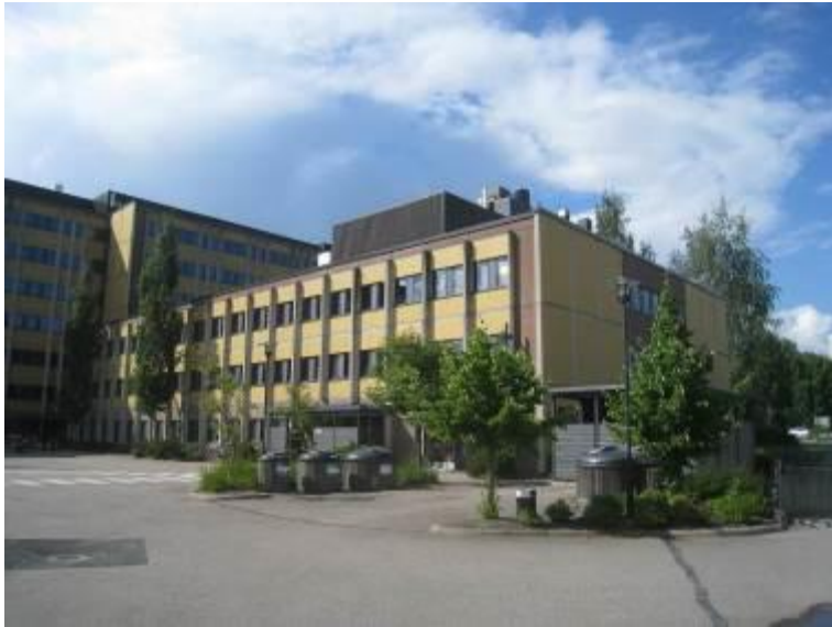
Kuva 24. Hippotalon pohjoinen julkisivu vuodelta 2012. /9/
