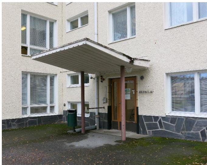
Kyy 166 : 54 Koukkuniemen Iltalan A portaan sisäänkäynti rakennuksen itäpuolella. Mircku Haapasaari 27.10.2015
