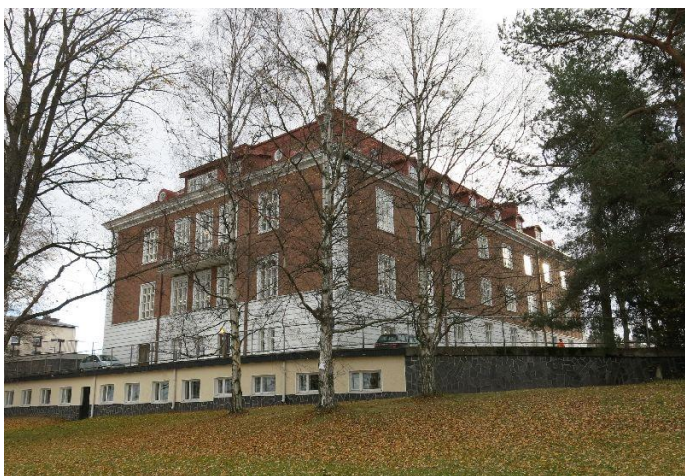
Kyy 166 : 39 Koukkuniemen Hallintorakennus lännestä kuvattuna. Etualalla huoltokäytävän seinää. Mirrku Haapasaari 27.10.2015
