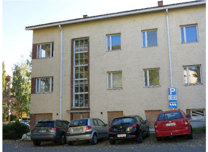
Kyy 166 : 37 Koukkuniemen Niksulan luoteisjulkisivua ja sisäänkäynti. Mirrku Haapasaari 09.10.2015
