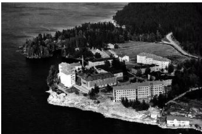
TKA E : 67 Koukkuniemen vanhainkodin rakennuksia
