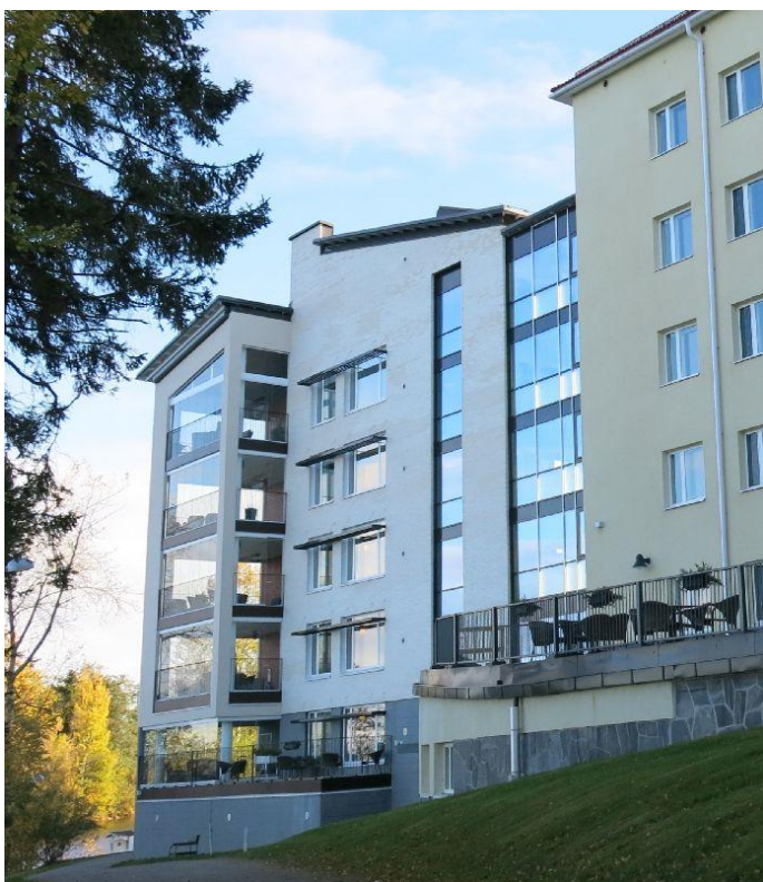
Kyy 166 : 5 Koukkuniemen Impivaaran luoteispäätyä ja liittyminen Jukolaan (keltainen rakennus oikealla). Mirkku Haapasaari 09.10.2015
