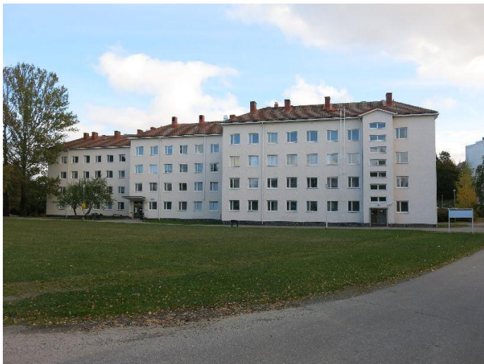
Kyy 166 : 6 Koukkuniemen Havulan luoteisjulkisivua. Mirkku Haapasaari 09.10.2015
