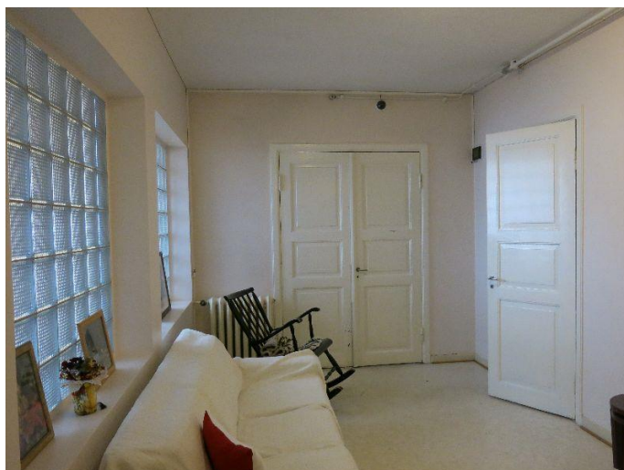
Kyy 166 : 47 Koukkuniemen Hallintorakennuksen ullakkokerroksen käytävää. Vasemmalla porrashuoneen puolella seinällä lasitiiltä. Päättyovi vie kylmään ullakkotilaan rakennuksen kaakkoispäädystä. Mirkku Haapasaari 27.10.2015
