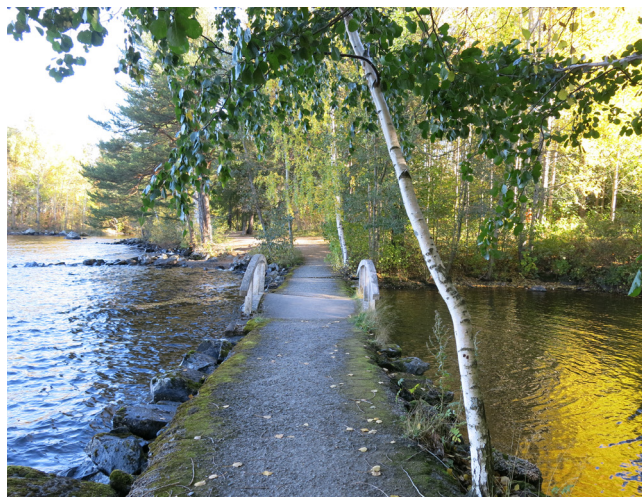
1930-luvulla rakennettu silta.
