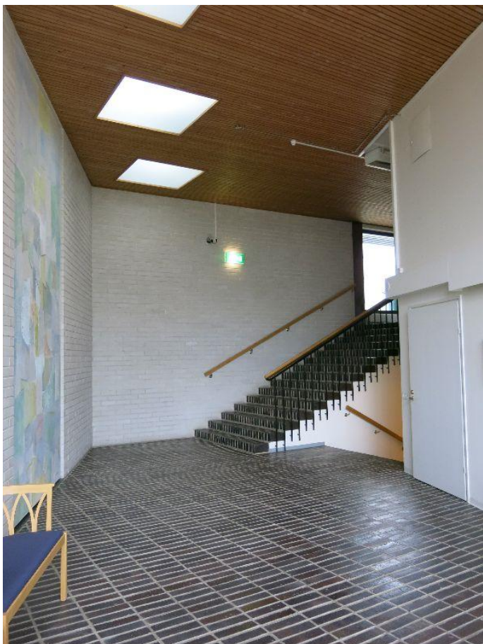
Kyy 166 : 64 Koukkuniemen Juhlatalon "halli". Oikealla ovi juhlasaliin. Takaosassa portaat ylös sisääntuloaulaan ja alas pohjakerroksen pylvässaliin. Mircku Haapasaari 27.10.2015
