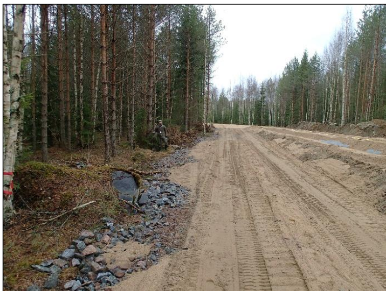
Tervärännin sijainti (vasemmalla seisovan henkilön kohdalla) suhteessa kaukolämpölinjaan.
