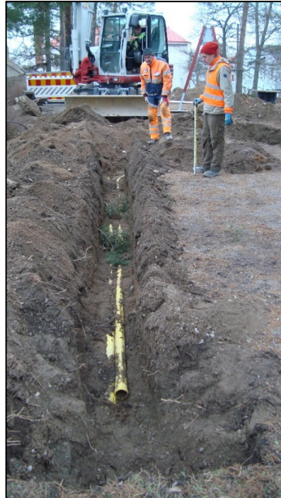
Kuva 20. Koeojaa 1, kuva luoteeseen.
