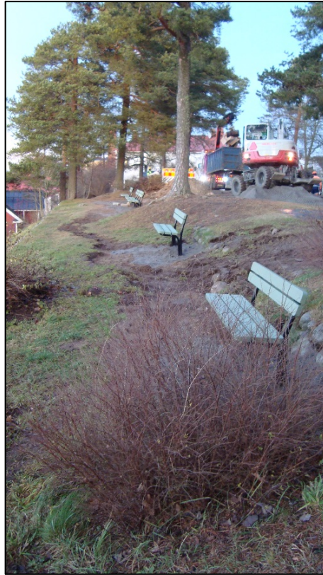
Kuva 12. Asennettuja penkkejä näköalapaikalla, kuva luoteeseen.
