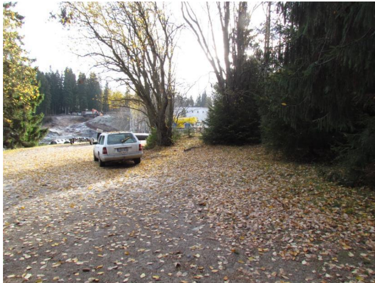
Kuva 6. Mahdolliset Kaupinojan sahan jätteet saattavat sijaita täyttökerrosten alla. Todennäköisesti kuvassa näkyvä kevyenliikenteen väylä on perustettu täyttömaan päälle.
