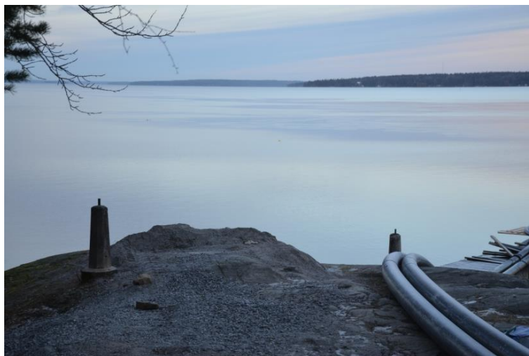
Kuva 7. Kaupinojanlahden molemmilla rannoilla on betonipylväitä, joiden päissä on kiinnittämiseen käytetty tappi. Rakenteet saattavat liittyä sahalle suuntautuneeseen uittotoimintaan tai valmiiden tuotteiden kuljetukseen käytettyjen lottien kiinnitykseen.
