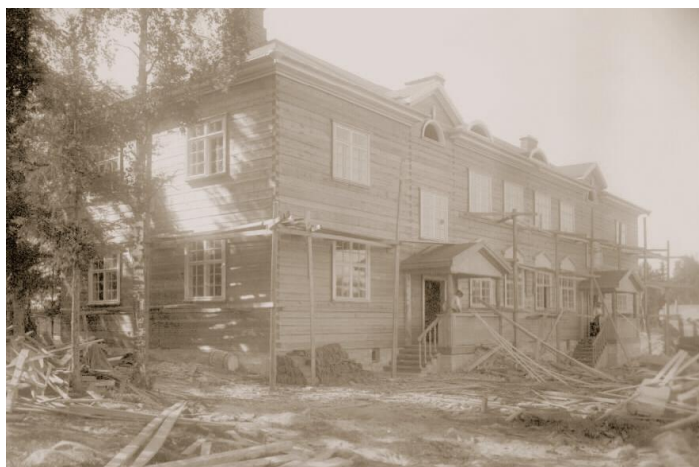
Tampellan työväen asuintaloja rakennetaan Vainion kadun eteläpuolella. (TMKA)
