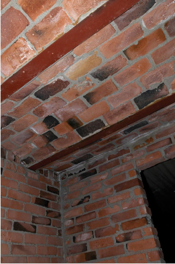
Kohteen omaa purkutiiltä käytettiin päätilan katon lisäksi myös uusissa väliseinissä sekä viini- ja ruokakellarin ladotuissa lattioissa. (kuva JL)
