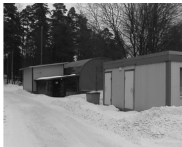
Jätevedenpuhdistamo ei puhdistaa jätevesiä riittävästi.
