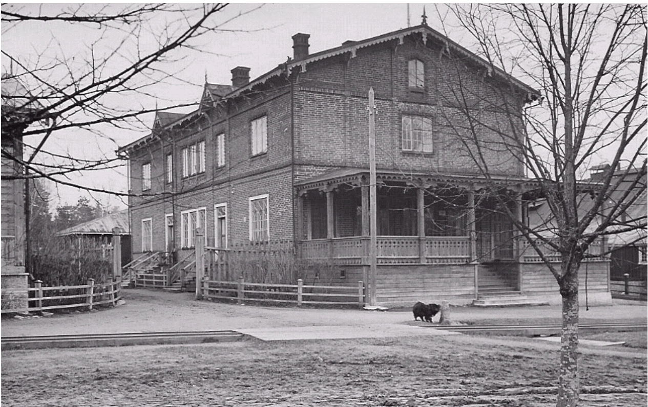
Kivimuuri ennen kerrosmuutosta. NLM.
