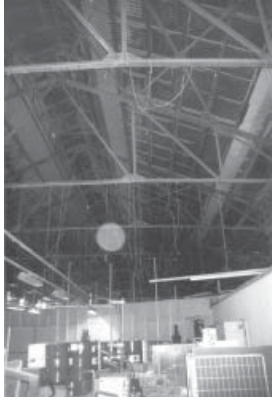
Hytin teräksisten kattoristikoiden kattamat korkeat tilat ovat komeita.
