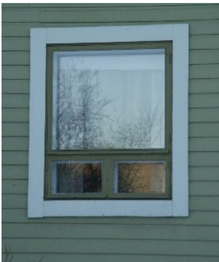
Yli 40 vuotta sitten uusitut ikkunat.
