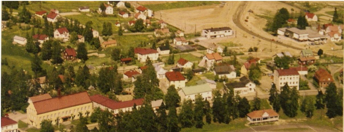
Harjun rakennuksia 1960-luvun alussa, ennen kirjaston ja HarjuCenterin rakentamista. Kuvassa näkyy muun muassa Rantasen Terijoelta tuodun asuintalon pääty. Rakennus on sittemmin purettu.
