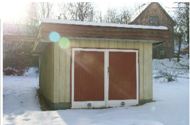
1970-luvun alussa rakennettu autotalli pohjoisesta.
