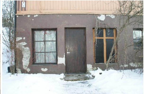
Pohjoispäädyn kivijalassa on tiettävästi ollut kauppa.
