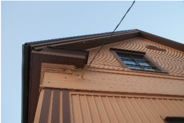
Rakennuksen vanha koristeellinen ulkovooraus.
