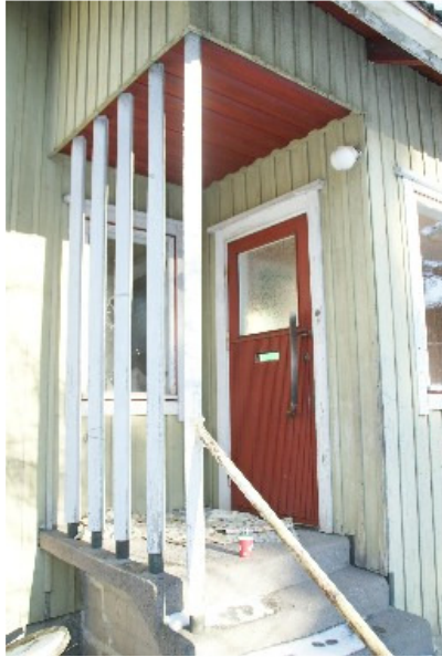
Alkuperäinen 1950-luvun kuisti.
