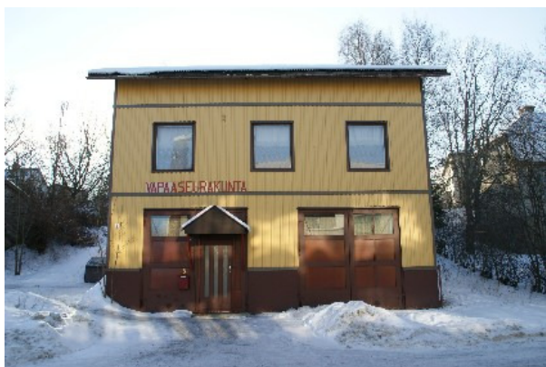
Julkisivu pohjoiseen, Välikadulle.
