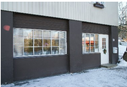
Entisen autotallin paikalle on tehty parturi-kampaamo.
