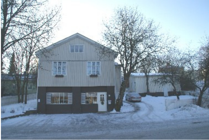
Julkisivu pohjoiseen, Välikadulle.
