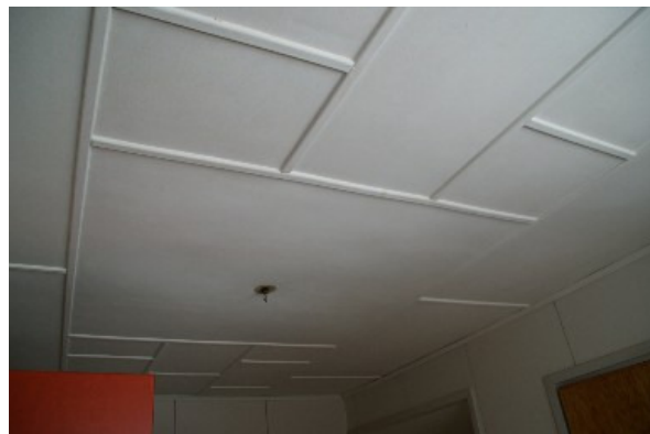
Osa katoista on pahvitettu ja rimoitettu.
