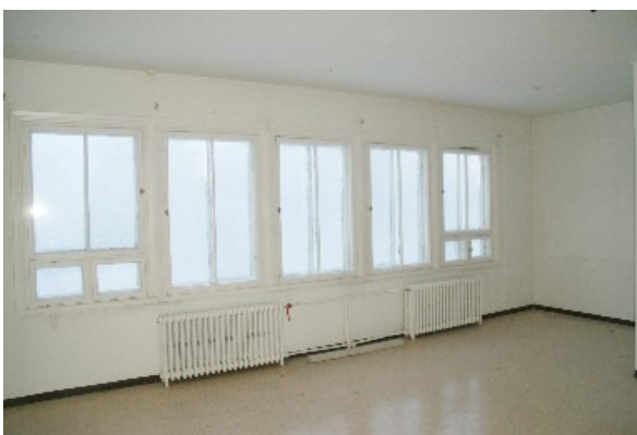
Yläkerran huone, ikkunat etelään. lautalattia.
