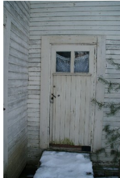
Eteläpäädyn vanha ulko-ovi.
