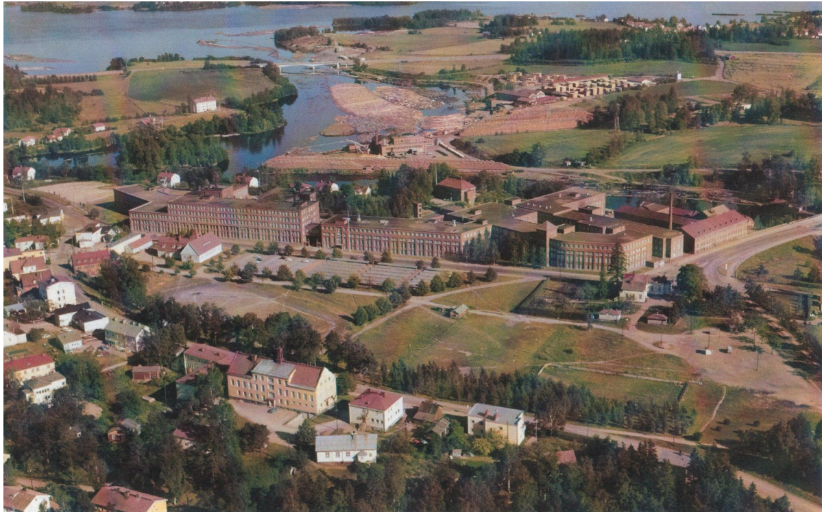
Harjun kaupparaitin hävinnyttä rakennuskantaa näkyy vielä 1970-luvun ilmakuvassa (kuvan vasemmassa alalaidassa). Kuva: Nokian kaupunki.
