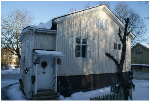
Pihanpuoleinen julkisivu etelään.
