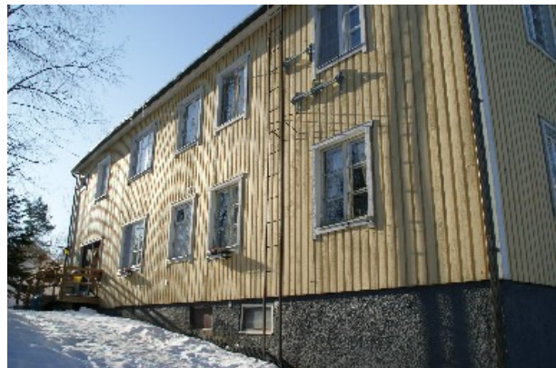
Rakennuksen sivu itään.
