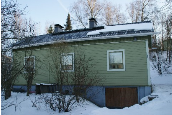
Julkisivu pohjoiseen, Välikadulle päin.
