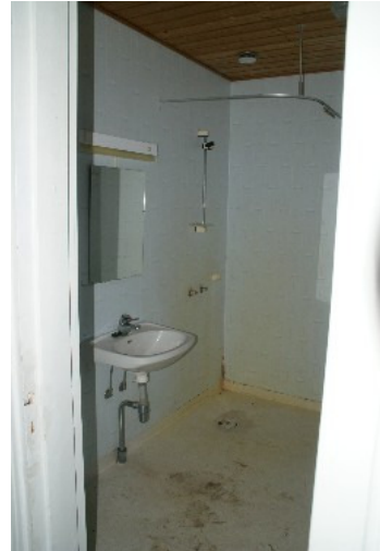
Yläkerran keittiön viereiseen isoon komeroon tehty suihkuhuone.
