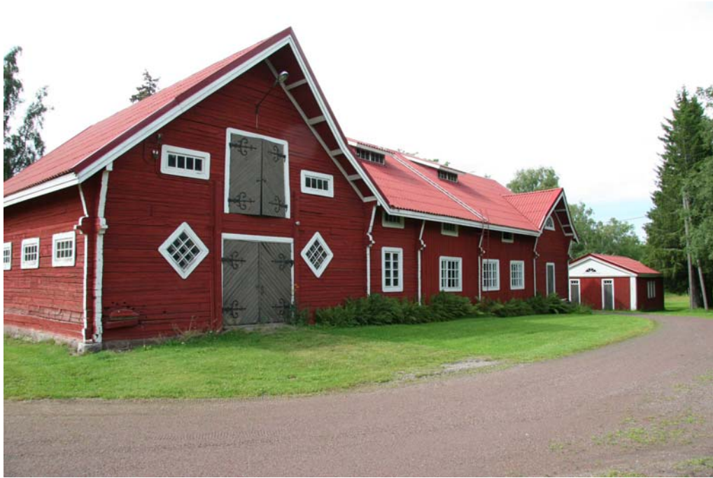
Kuva 8. Aittarakennus takaapäin. Vasemmalla vaunu- ja rekivaja sekä ovet tallin ylisille. Keskiosassa sijaitsi pakari ja maitohuone. Oikealla ovi makasiiniin. Taustalla autotallirakennus. (Valokuva Lasse Kosunen)
