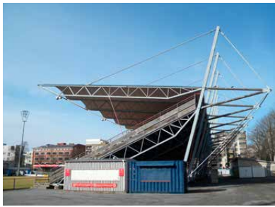
Stadionin pääkatsomo tällä hetkellä.
