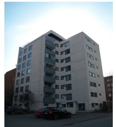
Ensimmäinen ”saneerauskaavan” mahdollistama kerrostalo Tammelassa sijaitsee tarkastelualueen rajalla, Mäkipääkatu 39-41.
