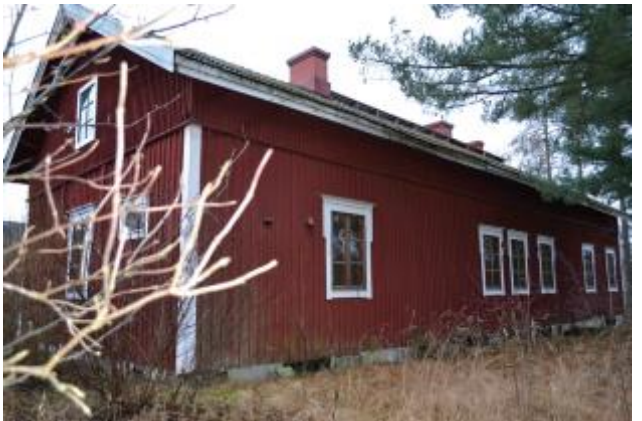
Takasivu pohjoiseen. Julkisivusta on purettu kuistit.
