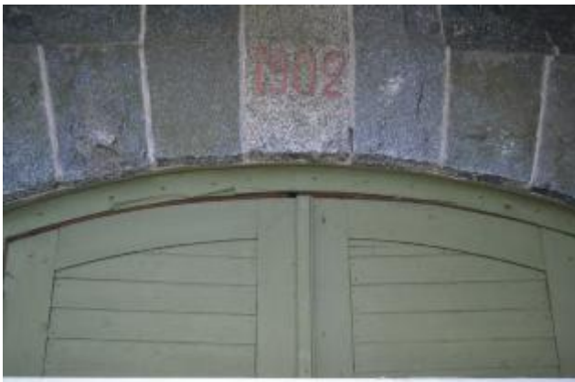
Pohjoissivun sisäänkäynti talliosaan. Rakennusvuosi 1902 hakattu oven yläpuolelle.
