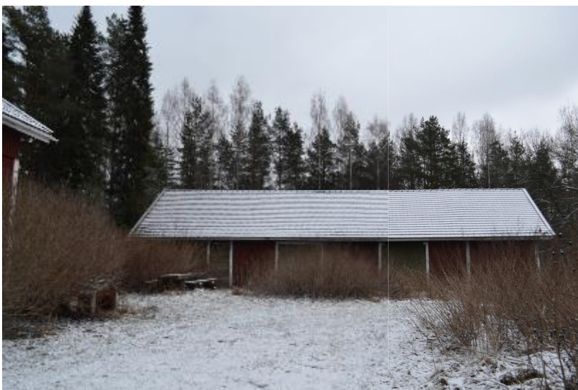
Näkymä vajalle pihan keskeltä. Rakennus sulkee pihapiirin neliömäiseksi.
