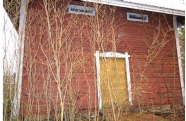
Sisäänkäynti- eli eteläsivu.
