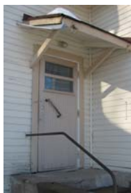
Kuva 15. Toinen eteläseinän ovista.
