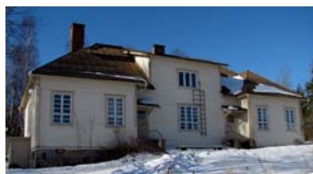
Kuva 1. Rakennuksen eteläpuoli eli pääjulkisivu.
