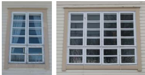
Kuva 16. ja Kuva 17. Alakerran ikkunat.
