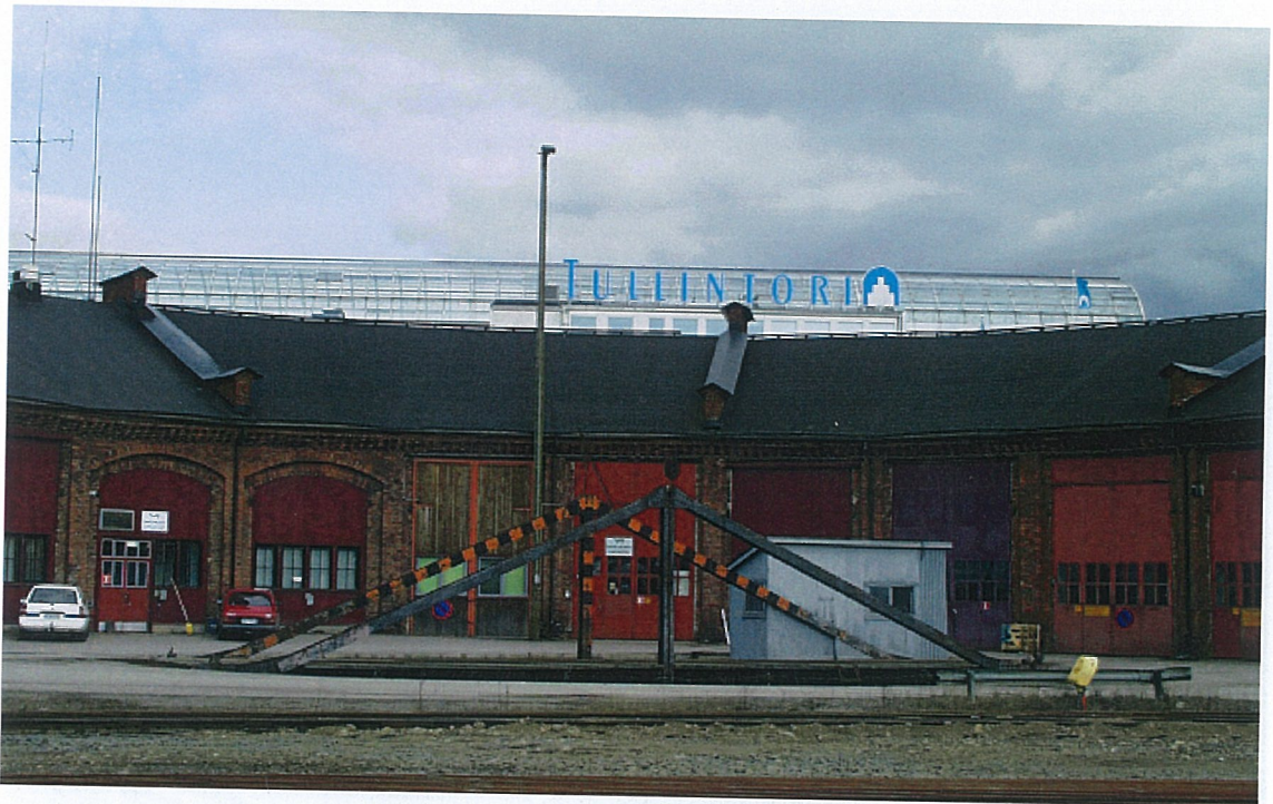
Kuva 20. Veturitallit ja tallien läheisyyteen muodostuvat tilat ovat poikkeuksellisia kaupunkirakenteessa. Vanhojen ulkotilojen muuttaminen sisätiloiksi lasikatteiden avulla on vaativa tehtävä. Taustalla Tullintorin lasikate.
